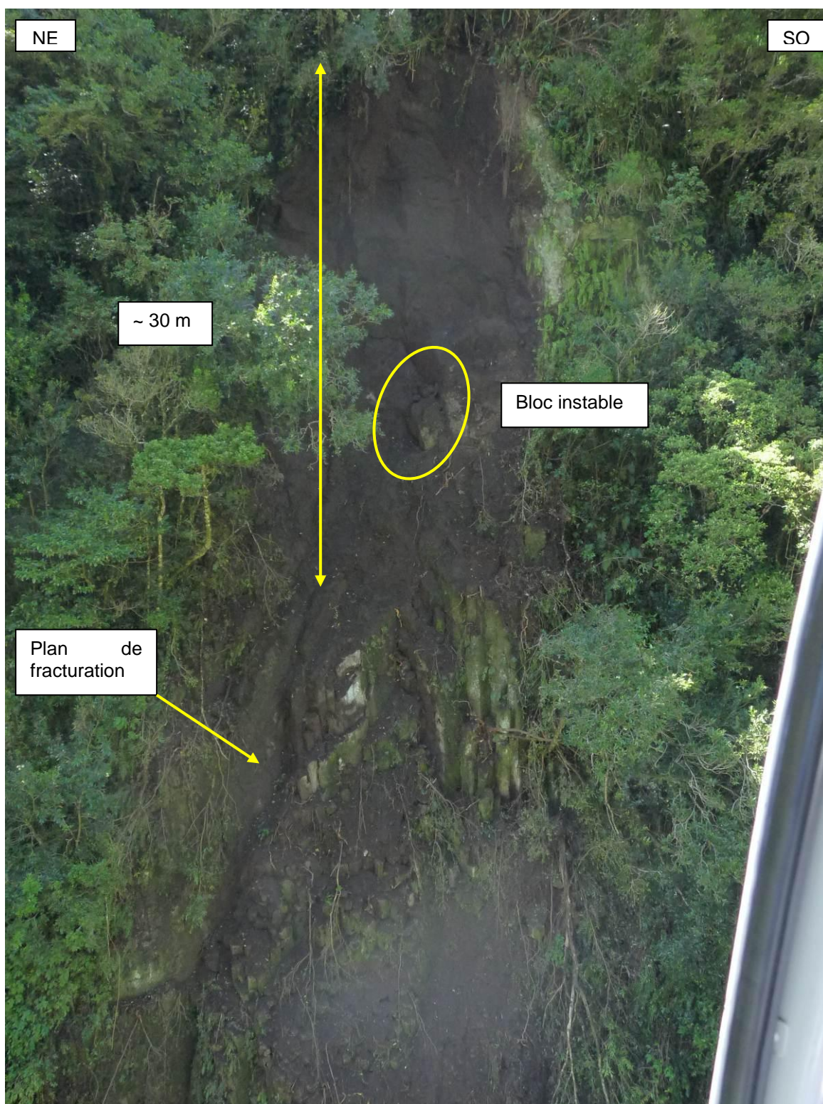
Figure 6 – Zone de départ de l'éboulement du 25 janvier 2014 au PR12+500
