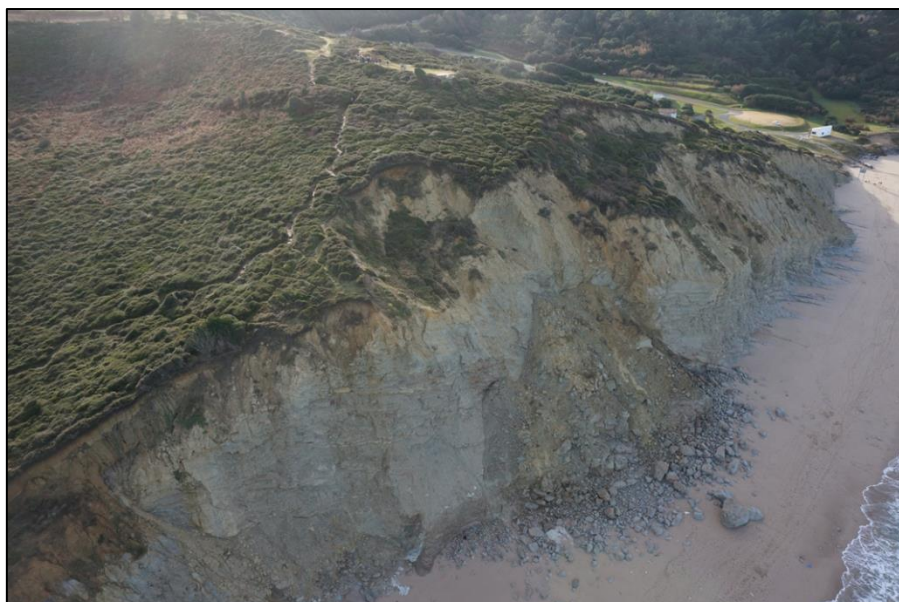
Figure 19 : Exemples de prises de vue par drone du 16/01/14 - cliché du bas : éboulement de novembre 2012.
