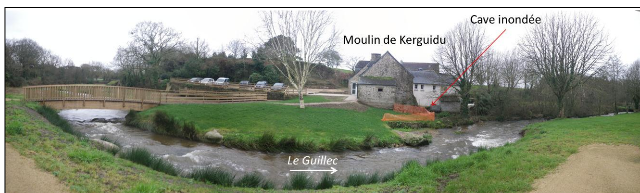
Illustration 12 : Localisation de la cave inondée en bordure du Guillec (photo BRGM, 31/01/2014)
