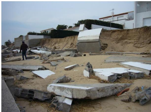
Figure 29 : Érosion de la dune et endommagement des habitations de première ligne (Point B61 de la Figure 28).
