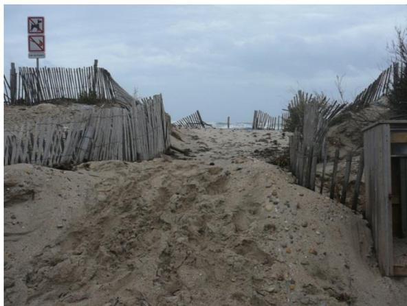
*Figure 62 : Overwash et ensablement de l'arrière-dune sur le Lido de Maguelone (source BRGM), tempête du 6 mars 2013.*
