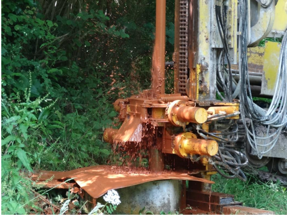
Illustration 5 : Photo prise au début du nettoyage au forage d'Auxais 01176X0046/S1
