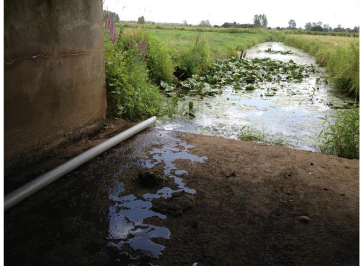
Illustration 19 : Photo du seuil au droit du pont de la D101, obstacle sur la Bucaille, sur le site de la Grosnière
