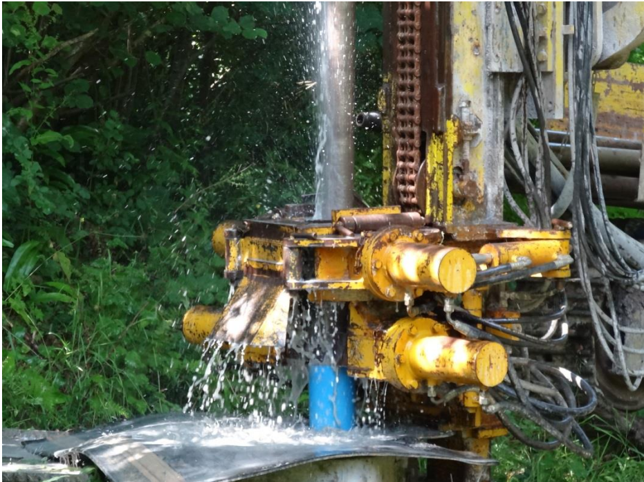
Illustration 6 : Photo prise à la fin du nettoyage au forage d'Auxais 01176X0046/S1
