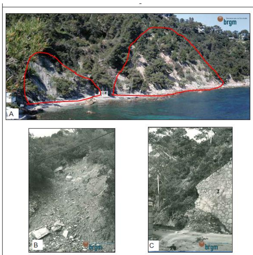
Illustration 36 : Glissement/Coulée (Toulon- Cap Brun 1955->1999 (récurrent) – Couverture l'altération de schistes) – Source rapport BRGM/RP59163-FR.
