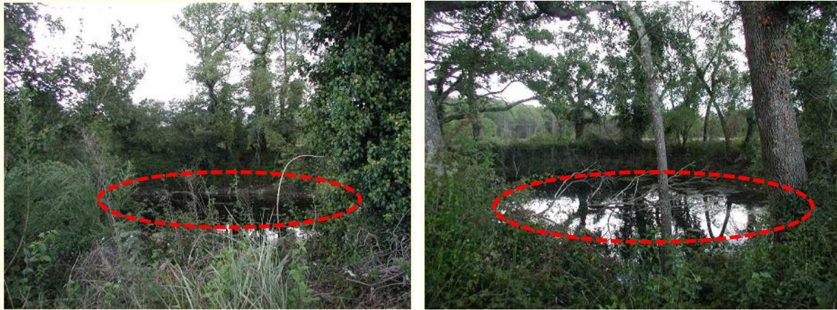
Illustration 32 : Effondrement (TOURRETTES – Etangs du Chautard - Formations gypseuse du Keuper) - source BRGM
