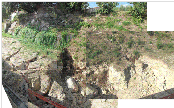
Illustration 28 : Effondrement (Trans-en-Provence - juin 2010 - 6 à 8 m de diamètre et 2 à 3 m de profondeur - marnes dolomitiques) – Source rapport BRGM/RP59163-FR
