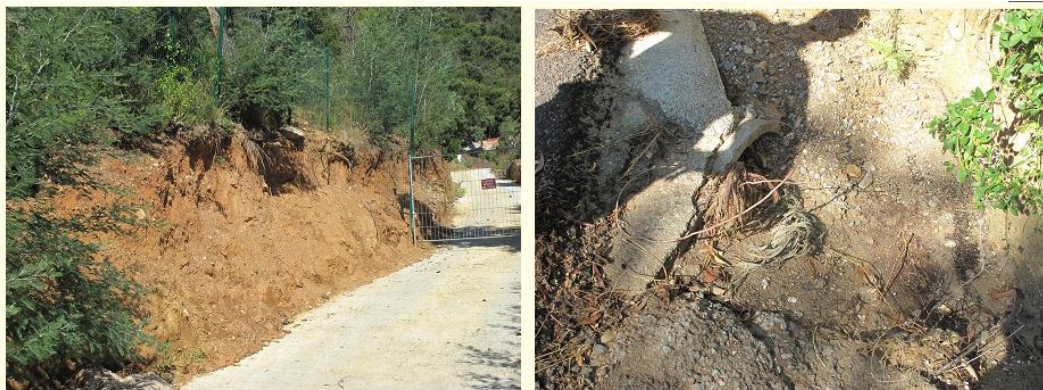
Illustration 35 : Coulée de boue : affleurement et canalisation obstruée par les matériaux coulés (RAYOL-CANADEL-SUR-MER - Hôtel Mimosa - 15/06/2010: Micaschistes) - Source BRGM
