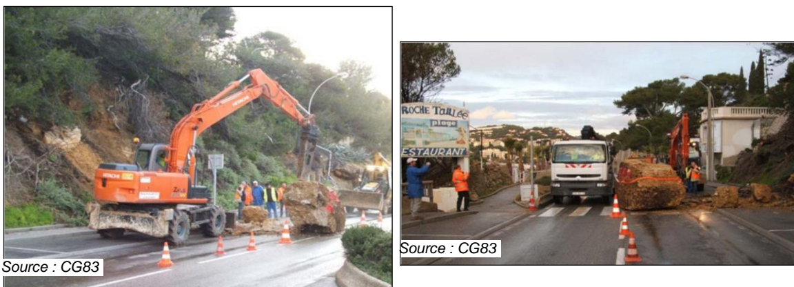
Illustration 24 : Chute de blocs (Sanary-sur-Mer – 8 au 9 janvier 2009 - bloc de 20 tonnes sur la RD559 - conglomérats, sable et marnes) - Source CG83 et rapport BRGM/RP59163-FR
