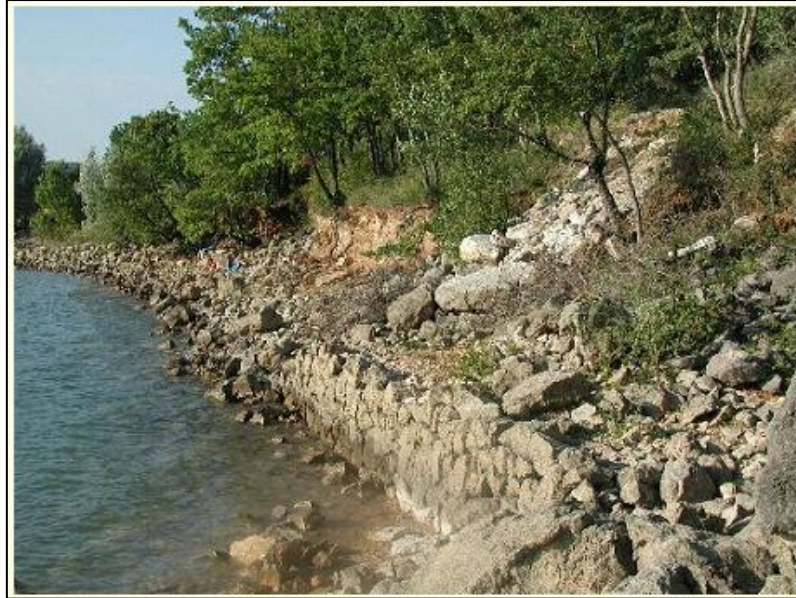
Illustration 25 : Erosion de berges et mise en place d'un mur de soutènement pour ralentir le phénomène (BAUDUEN – Lac de Sainte-Croix – 1980 - colluvions, éboulis et enrochements emportés) - Source BRGM
