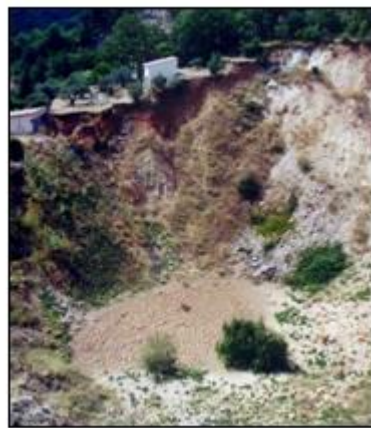
Illustration 30 : Effondrement (BARGEMON – Quartier Peyrui – 80 m de diamètre et 15 m de profondeur 22/08/1992 - Formations gypseuse du Trias et calcaréo-dolomitiques du Muschelkalk) - source rapport BRGM/RP59163-FR et LRPC Aix-en-Provence
