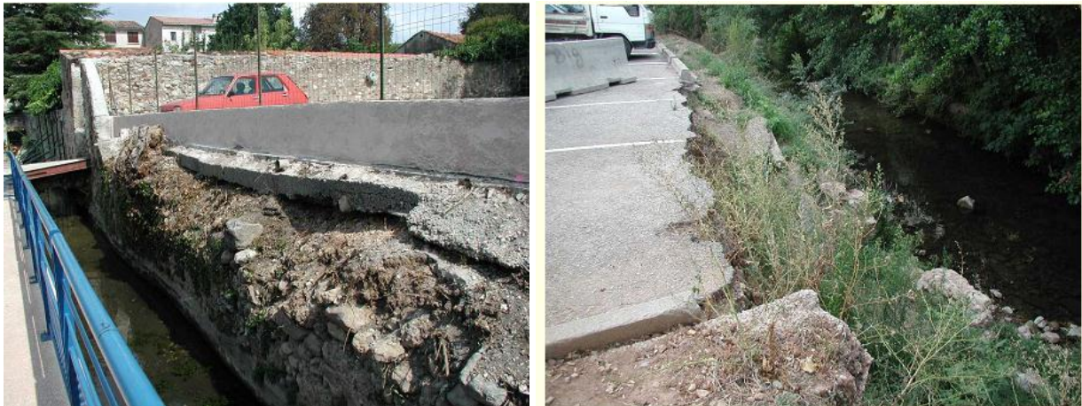
Illustration 26 : Erosion de berges (SOLLIES-PONT- Berges du Gapeau - 18/01/1999 – Alluvions récentes)- Source BRGM
