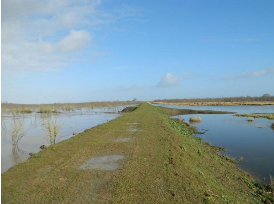
*Figure 20 : Digue qui sépare le bassin nord (à gauche) du reste de l'île Nouvelle (à droite). Noter l'envasement visible sur la photo à gauche (photo janvier 2013).*
