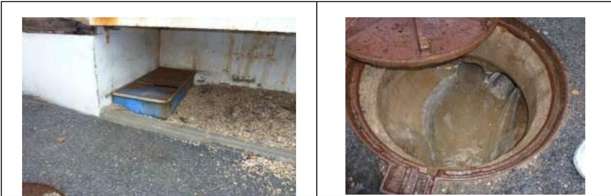
Figure 108 : Bac à graisse et tampon en sortie de cette installation.
