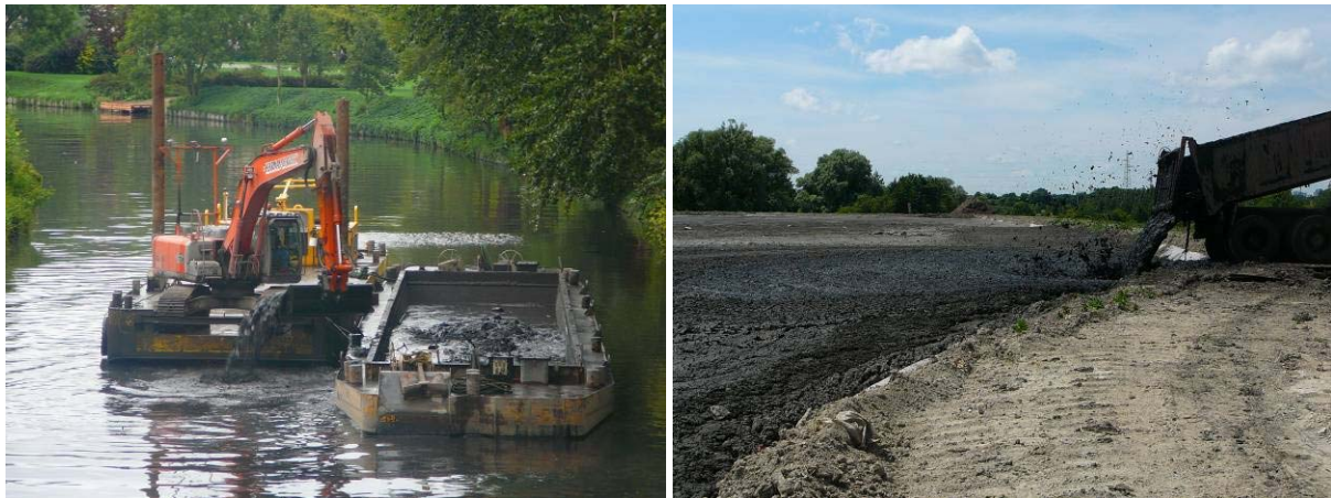
Figure 6 : Curage non sélectif et mise en dépôt, Canal de Lens, 2010.
