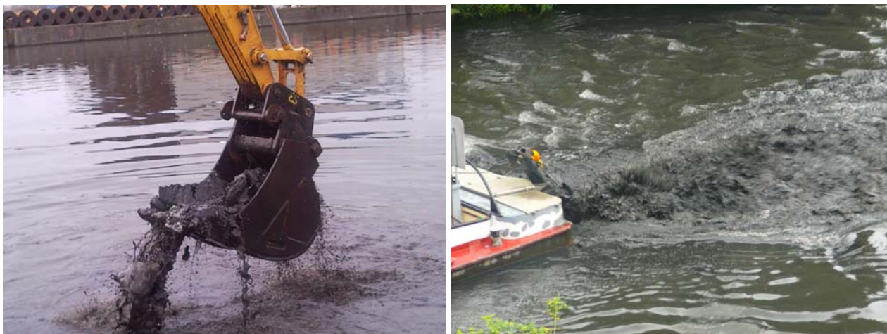
Figure 14 : Remise en suspension des sédiments par le curage (gauche) et la navigation (droite).
