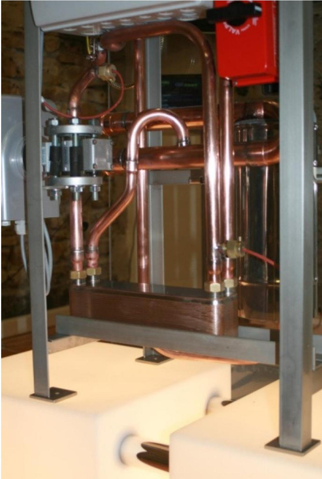
*Illustration 166 : Détail d'une installation CalH<sub>2</sub>O (Domelys) exploitant un échangeur à plaques*
