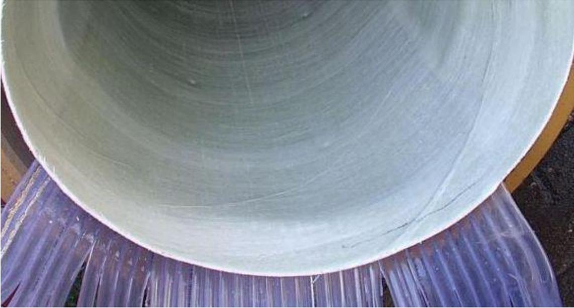
Illustration 140 : Vue de la gaine une fois durcie (polymérisée) et des tuyaux de l'échangeur
