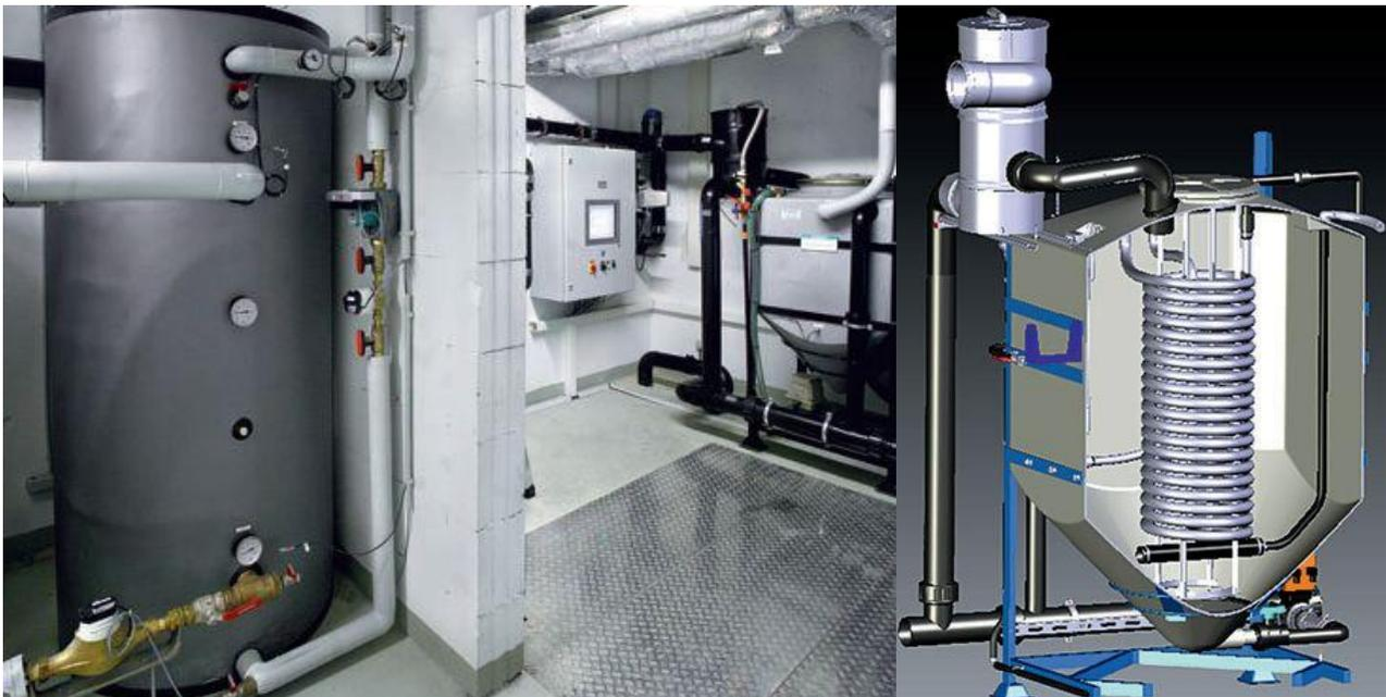
Illustration 168 : Dispositif HEATCYCLE couplé à un accumulateur FORSTNER à Freiburg
