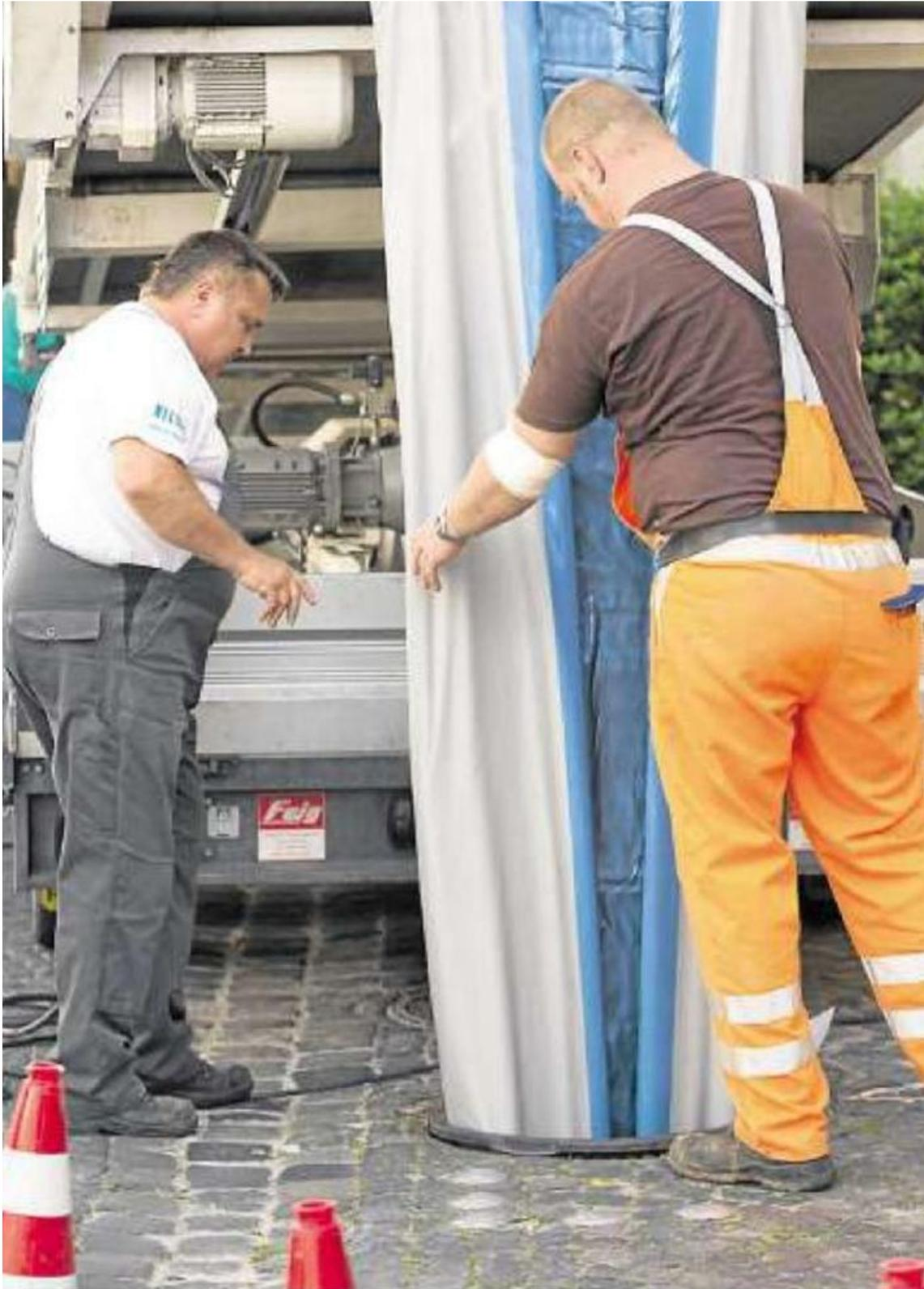
*Illustration 142 : Exemple d'étape de mise en place du système Heatliner avec gaine durcissable*
