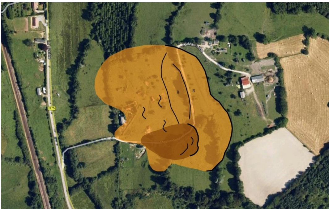
Illustration 13 : Vue en plan du phénomène. En orange le glissement originel, probablement déjà réactivé par le passé, en marron, sa réactivation de 2001.
