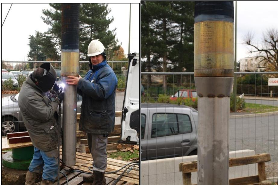
*Illustrations 12 et 13 : Ajout d'un cône de guidage sous le packer de pied*
