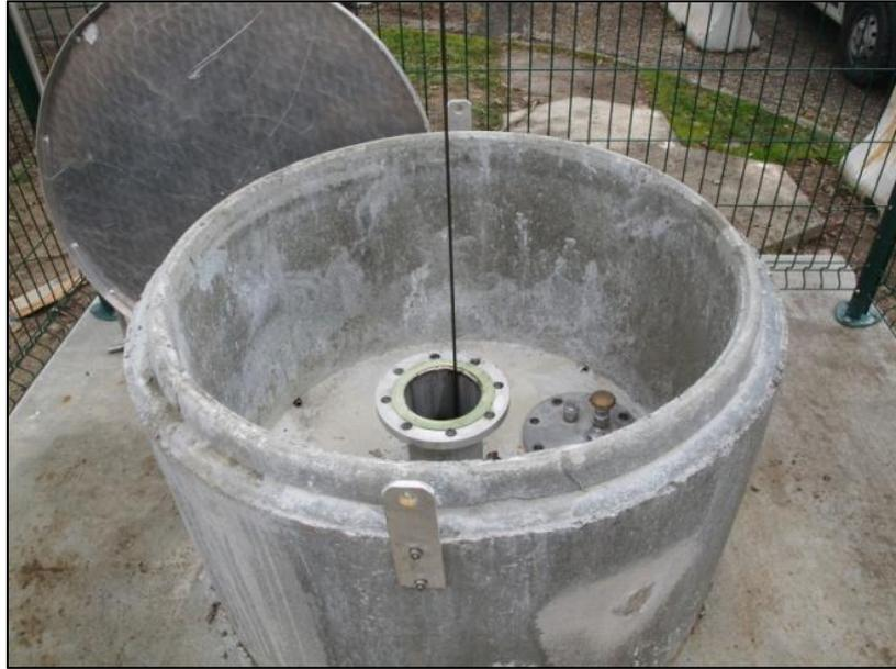
*Illustration 19 : Travaux d'aménagement (buse béton, tête du forage et plaque en acier)*
