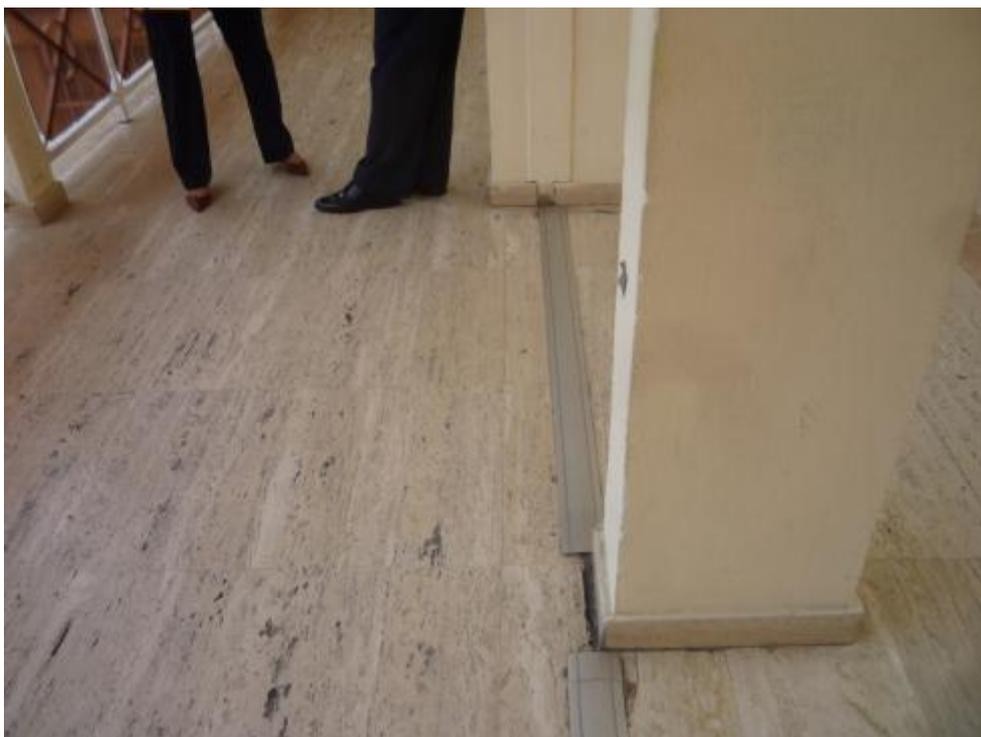
*Figure 91 : Joint non PS entre les parties nouvelle et ancienne dans la section centrale du bâtiment.*
