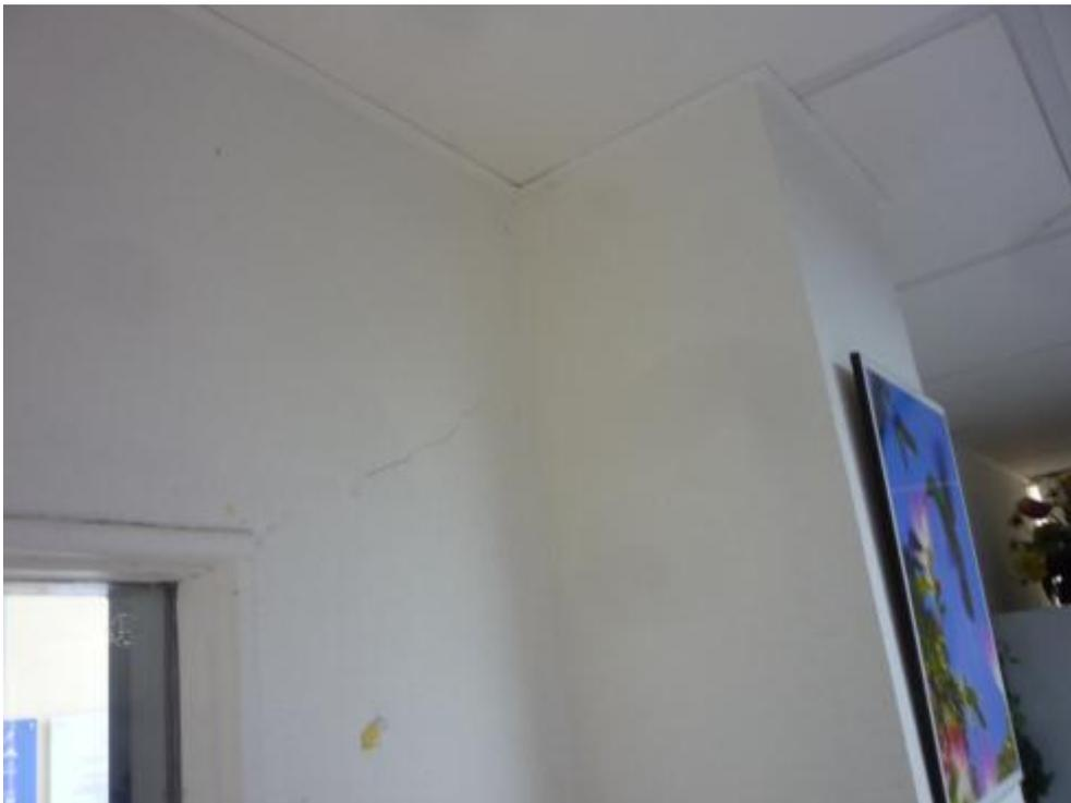
*Figure 105 : Exemple de fissure dans les remplissages intérieurs*
