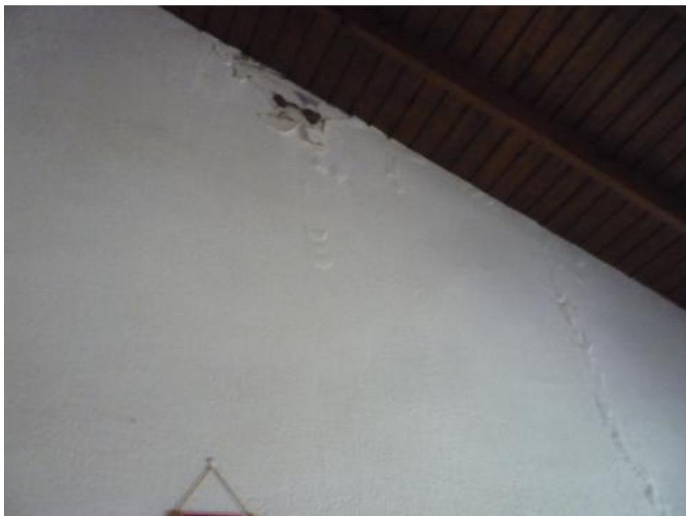
*Figure 108 : Vue intérieure, plancher en bois et endommagements d'humidité*
