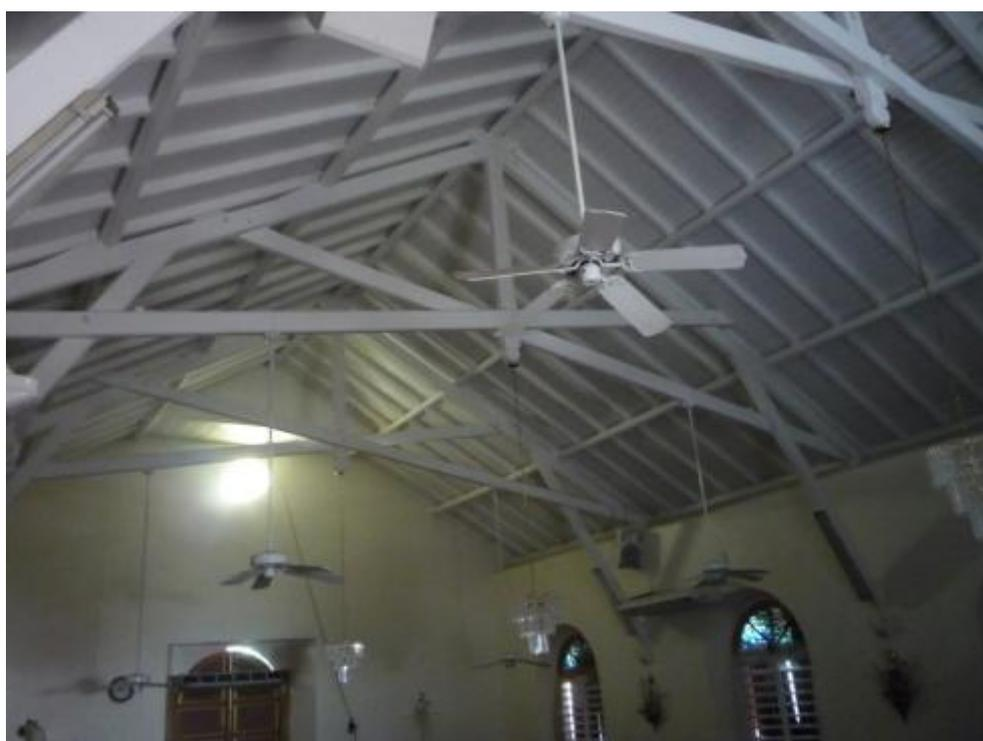
*Figure 96 : Ossature en bois du toit.*
