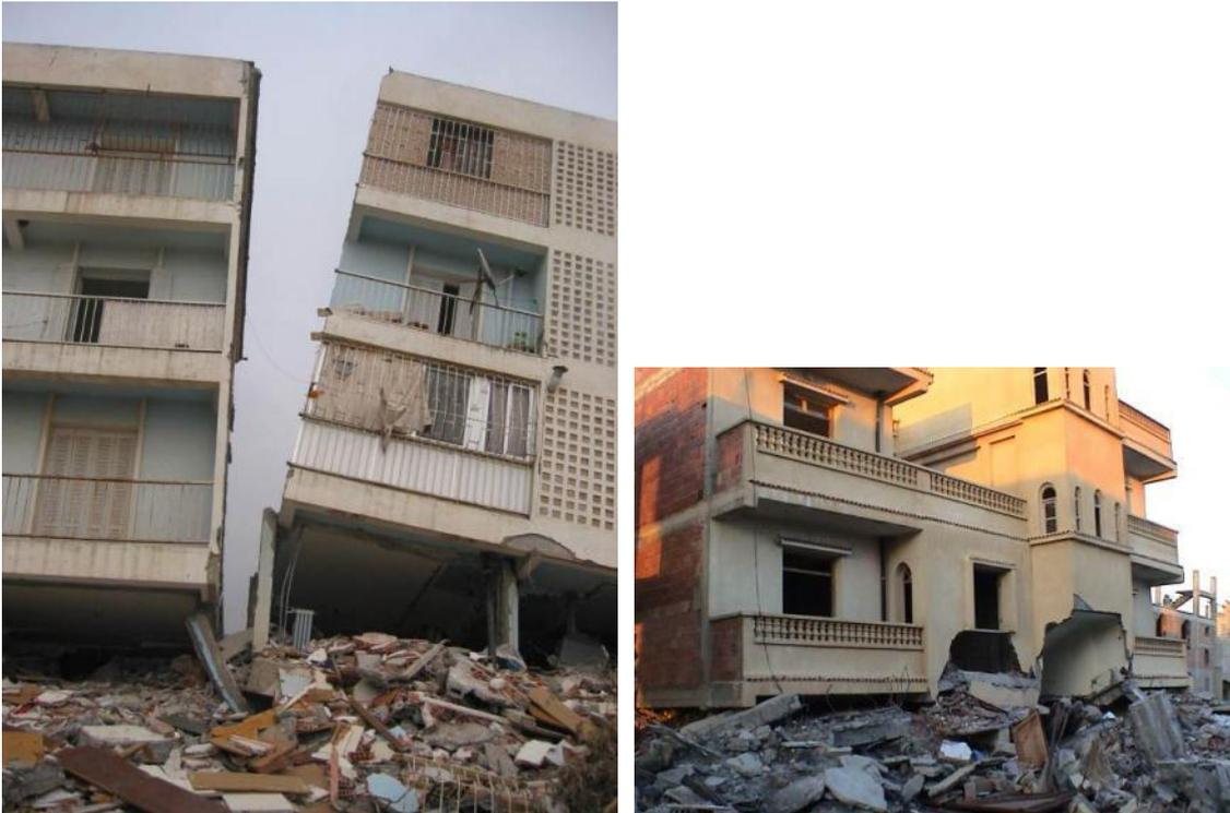
Figure 56 : Effondrement du RdC lors du séisme de Boumerdès en Algérie en 2003.
