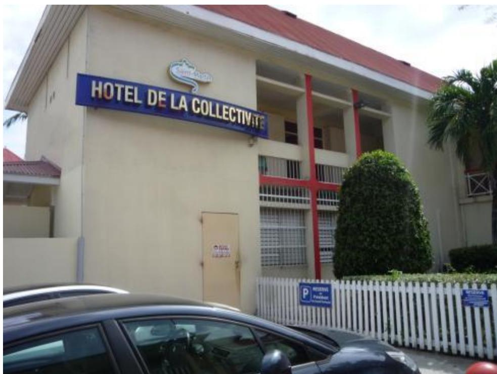
Figure 89 : Façade frontale de l'aile gauche (partie ancienne). Trumeaux aux extrémités, portiques avec possibles poteaux courts au centre.
