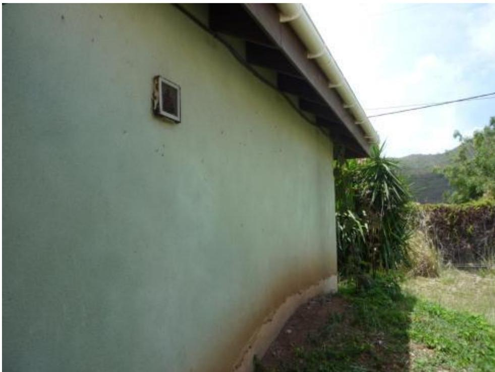
*Figure 107 : Vue postérieure, mur en béton armé adapté à la pente*
