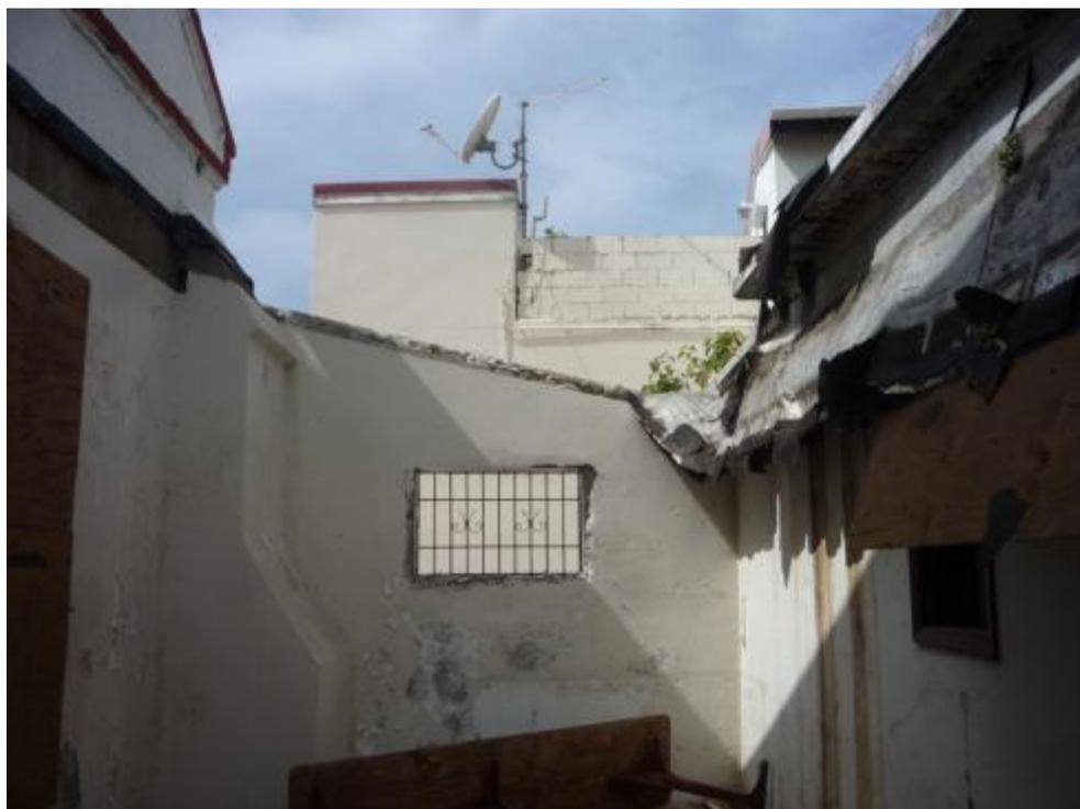
*Figure 95 : Façade postérieure, contrefort longitudinale et partie à l'abandon*
