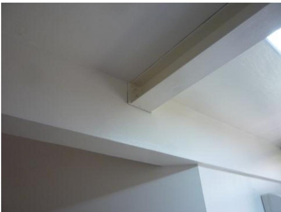
*Figure 92 : Poutres en acier de la partie nouvelle (aile droite) du bâtiment.*
