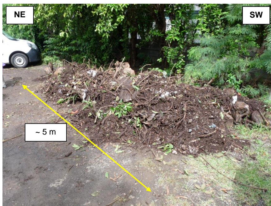
Figure 4 : Volume de matériaux purgés à l'issue des travaux
