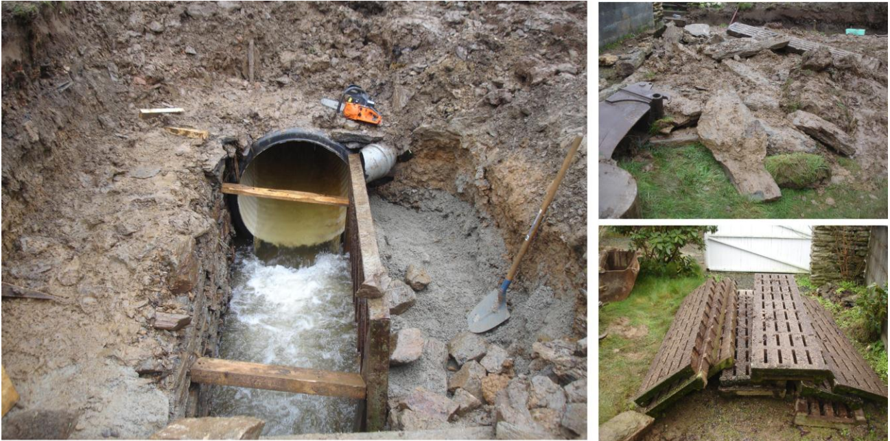
Illustration 14 : Cours d'eau busé en amont de l'effondrement par une buse plastique alors que celui-ci était canalisé par des murs de pierres, recouverts de schistes en haut à droite puis remplacés de dalles béton en bas à droite.
