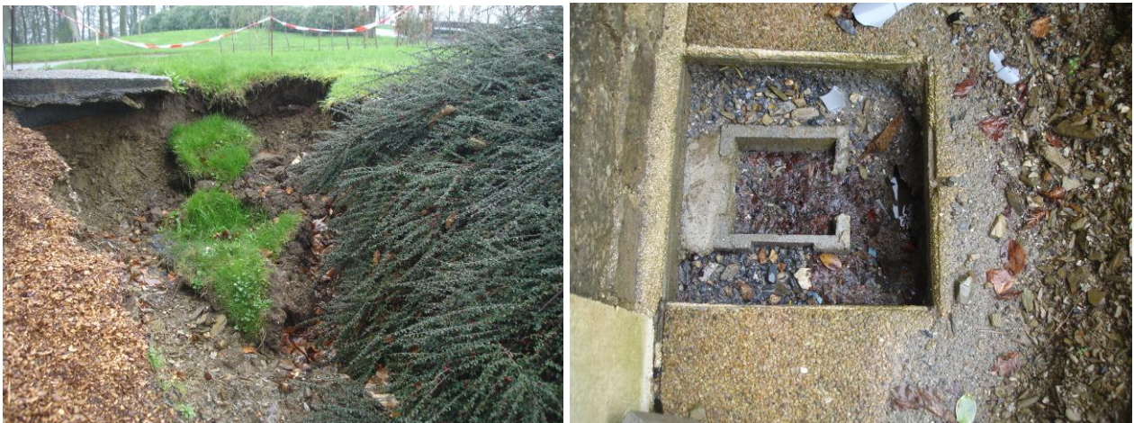
Illustration 12 : A gauche : photographie du sinistre (ravinement-glisserment sous la terrasse) ; A droite, récupérateurs de eaux de toiture obstrués
