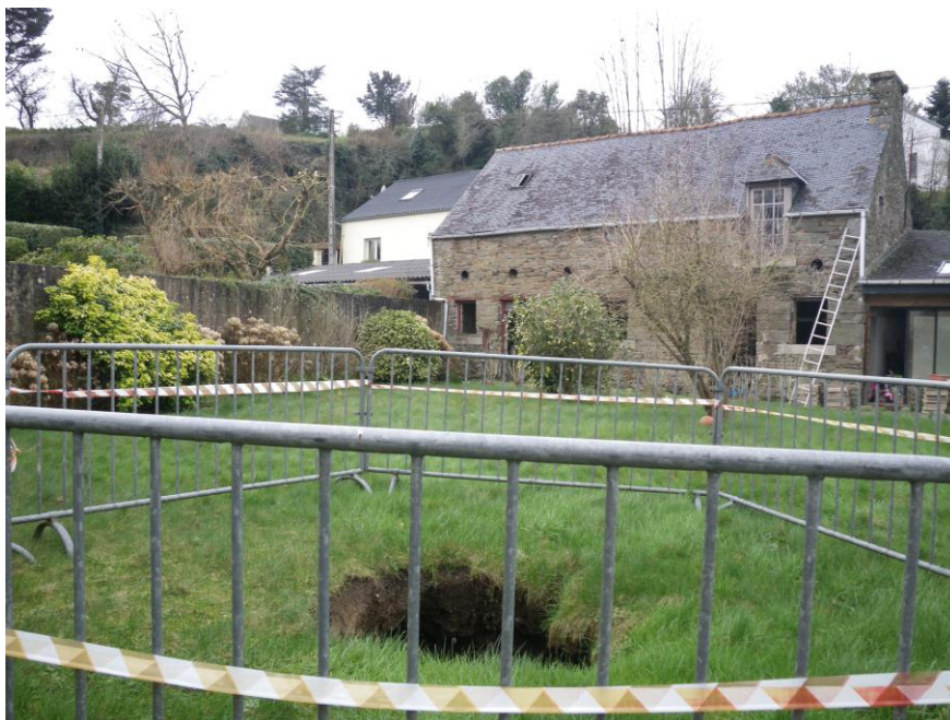
Illustration 13 : Photographie de l'effondrement
