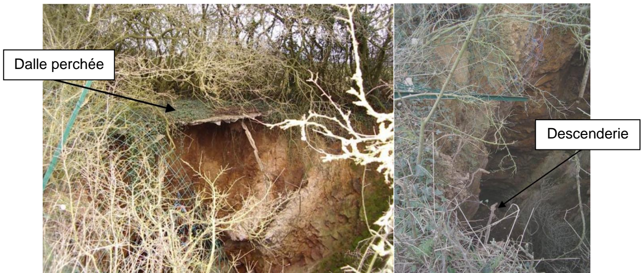
Illustration 15 : Effondrement de terrain au dessus de le descenderie de La Boisière, Commune de Trémusson
