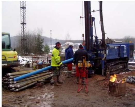
*Illustration 112 - Forage du nouveau piézomètre PZ Gazomètre Amont.*
