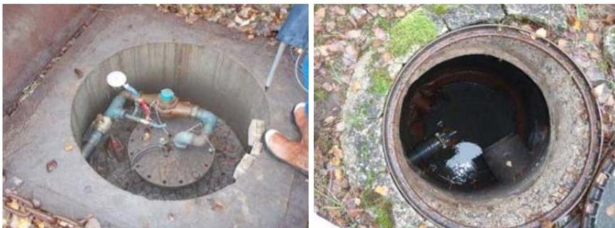
*Illustration 113 - Les regards de pompage et de prélèvement du forage gazomètre.*
