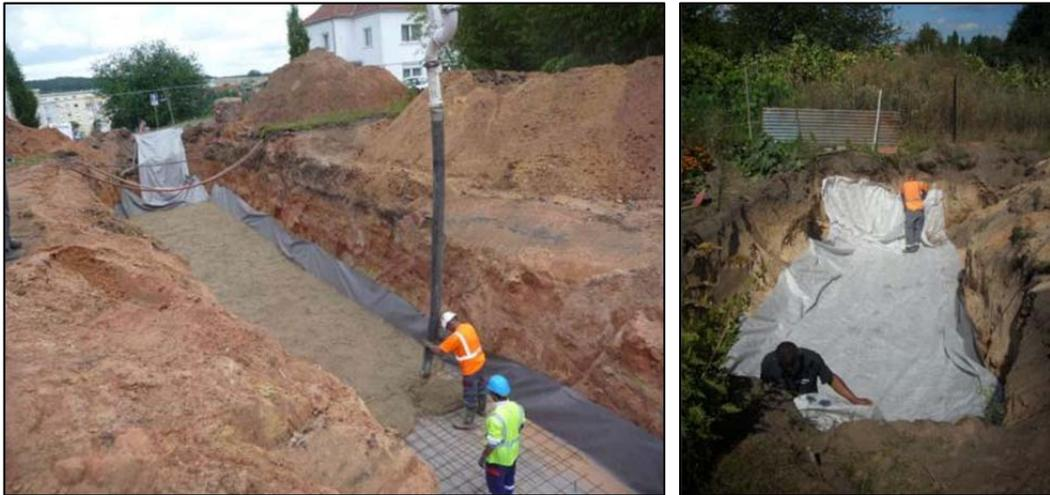
*Illustration 121 - Traitement de crevasse par radier béton à Freyming-Merlebach en juin 2012, et par mise en œuvre d'un géotextile à Rosbruck en août 2012.*
