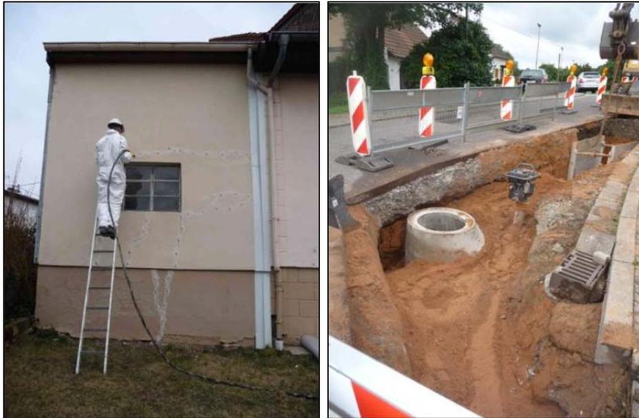
*Illustration 122 - Traitement de fissures en mars 2012 et réparation du réseau d'assainissement en juin 2012 à Nassweiler (Allemagne).*
