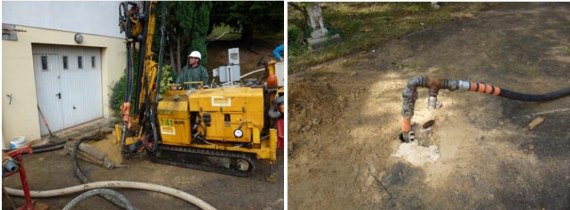
*Illustration 93 - Mise en place d'une foreuse – Injection de coulis par le trou de forage.*
