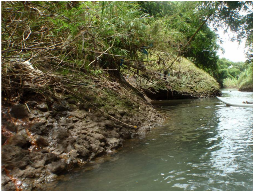
Illustration 24 : Conglomérat sain, à la base des berges, constitué d'éléments de 10 à 20 cm de diamètre (Point 282)
