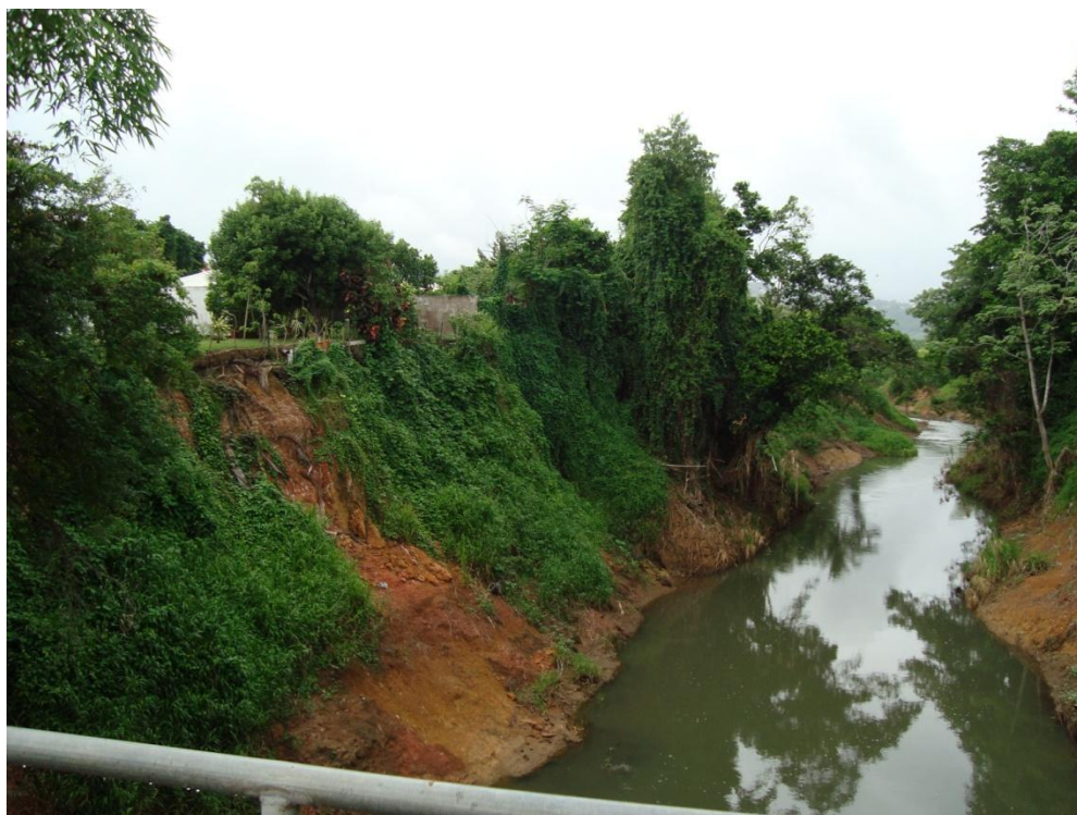
Illustration 69 : Amont immédiat du pont de Ressource
