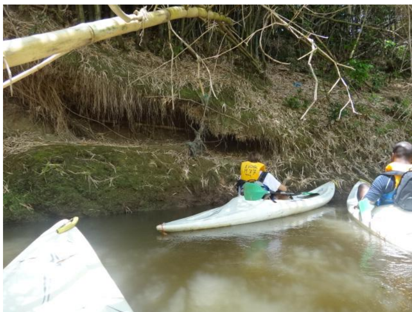
Illustration 29 : Sous-cavage des alluvions provoqué par le système racinaire des bambous (Point 273)
