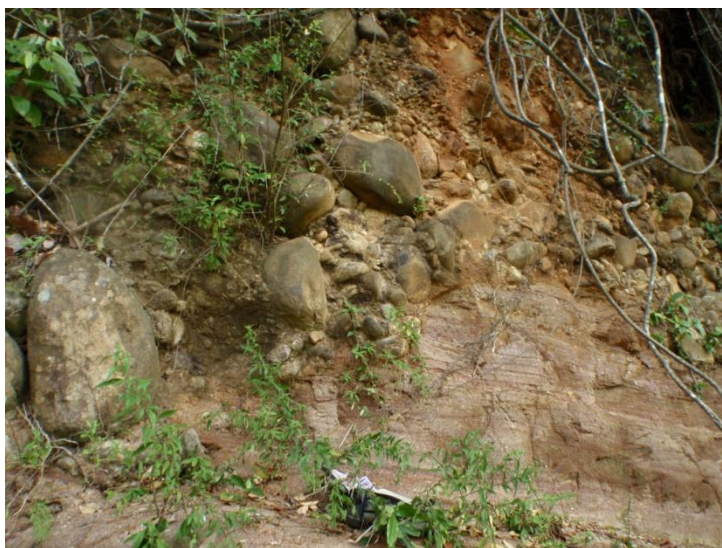
Illustration 31 : Déchaussement de blocs dans les conglomérats anciens (Point 290)
