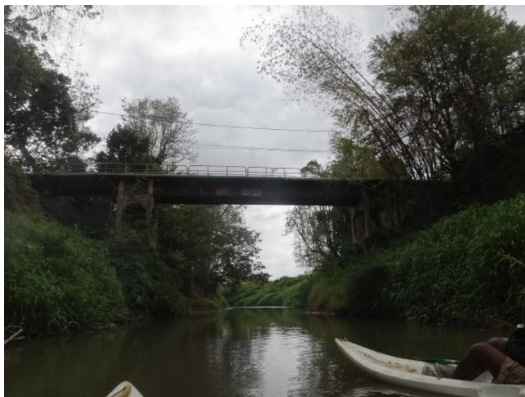
Illustration 56 : Enfoncement du lit (sans déviation latérale), au niveau du pont de Ressource (Point 434)
