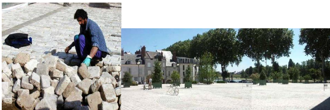
Figure 2 - Chantiers phares du centre-ville sur la période 2004-2006 (source : Mairie d'Orléans).
