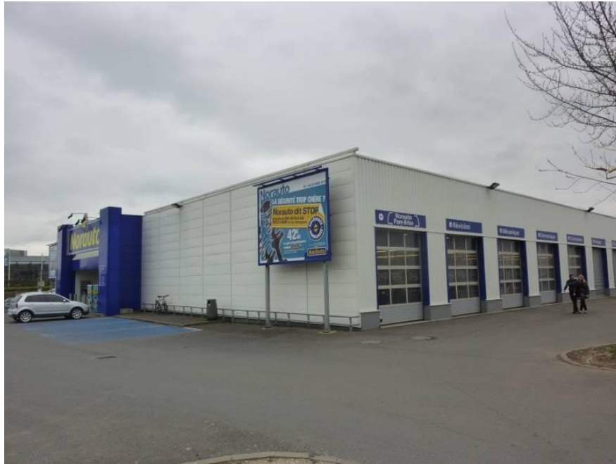
Bâtiment industriel (garage) en ossature métallique.
