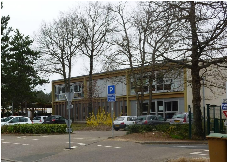
École à Orléans-la-Source. Ossature en béton armé mais sans remplissage en maçonnerie en façade.
