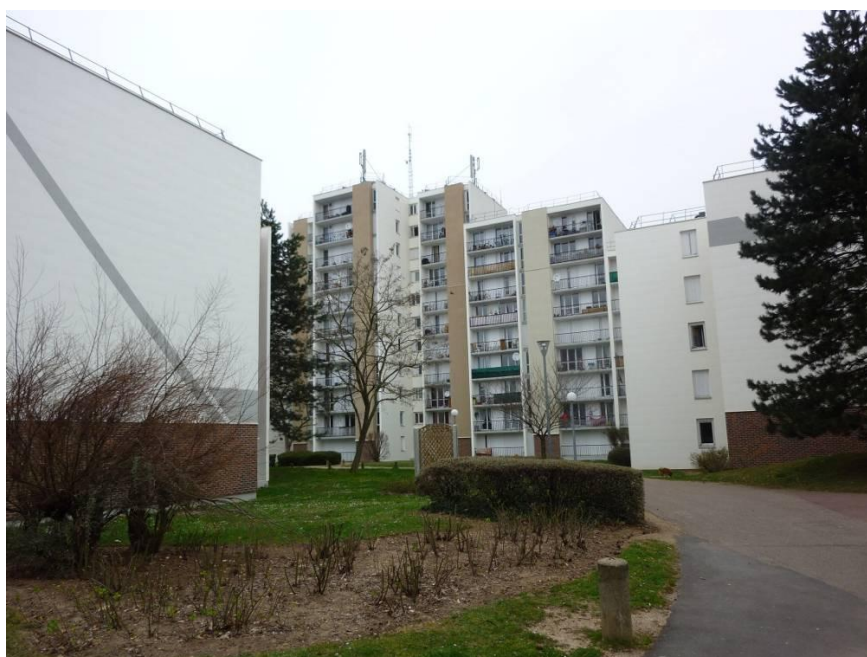
Cité d'habitat collectif à Orléans-la-Source (système en voiles).
