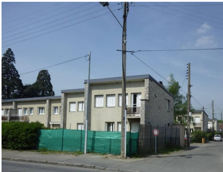
Lotissement construit entre les années 1950-1960. Mélange de deux maçonneries.
