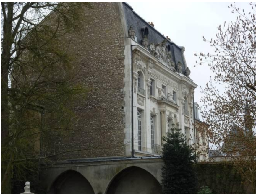
Bâtiment en maçonnerie en pierre. Façade en pierres de taille et mur latéral en pierre tout venant.
