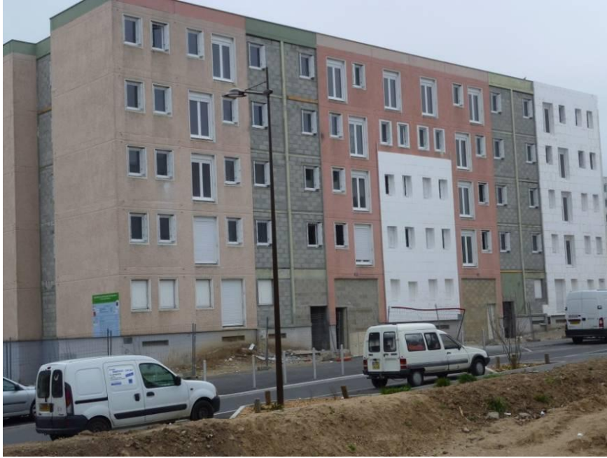
Bâtiment type HLM, ossature en béton (coffrages tunnel) et remplissage en agglomérés (Orléans-la-Source).
