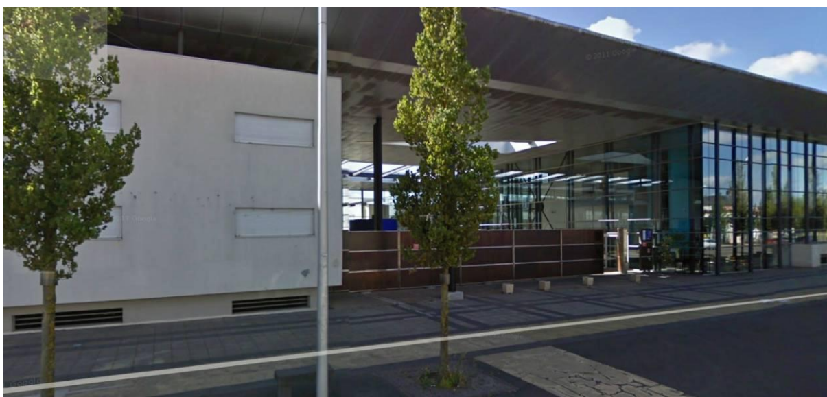
Bâtiment scolaire récent. À gauche structure en voiles, à droite charpente métallique et vitres (Google Street).
