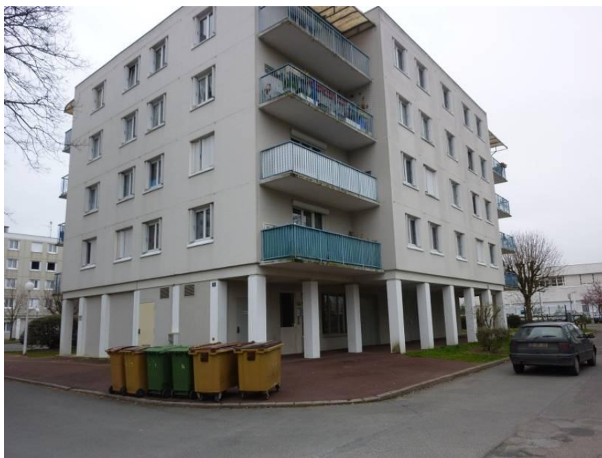
Bâtiment en poteaux-poutres et remplissage.
