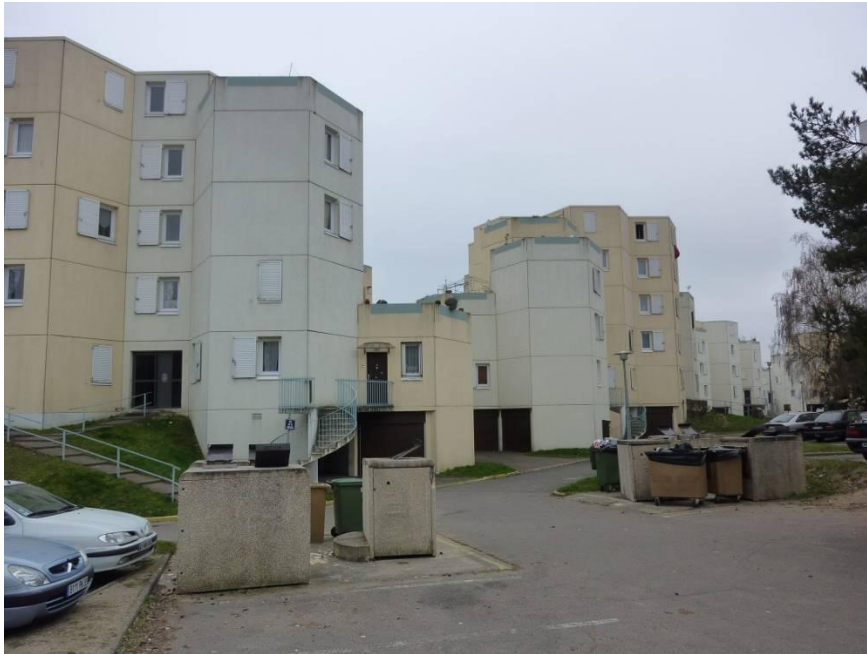
Bâtiment avec des murs préfabriqués en façade (Orléans-la-Source).
