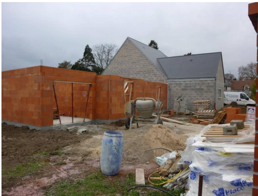
Pavillon en construction.
