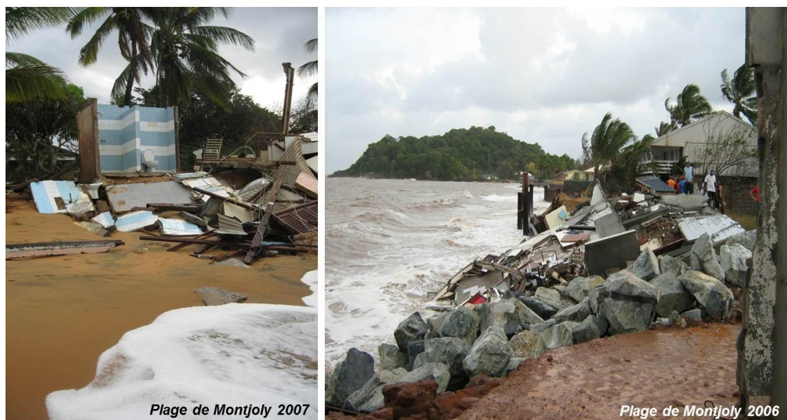
Figure 4 - Dégâts générés par l'érosion littoral sur la plage de Montjoly entre 2006 et 2007 (BRGM)
