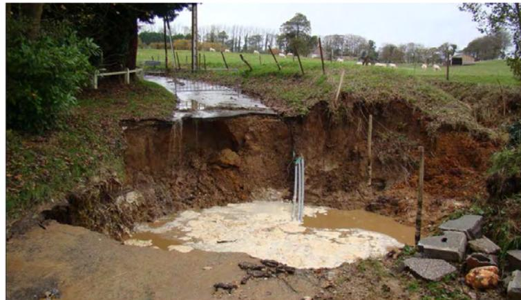
**Doline Bétoire n°10079** : effondrement du 04/11/2009 au niveau d'une route à Saint Jouin de Bruneval – diamètre de l'ordre d'une dizaine de mètres (observation du 06/11/2009) – Bétoire recevant les eaux des talwegs inondés à l'amont
