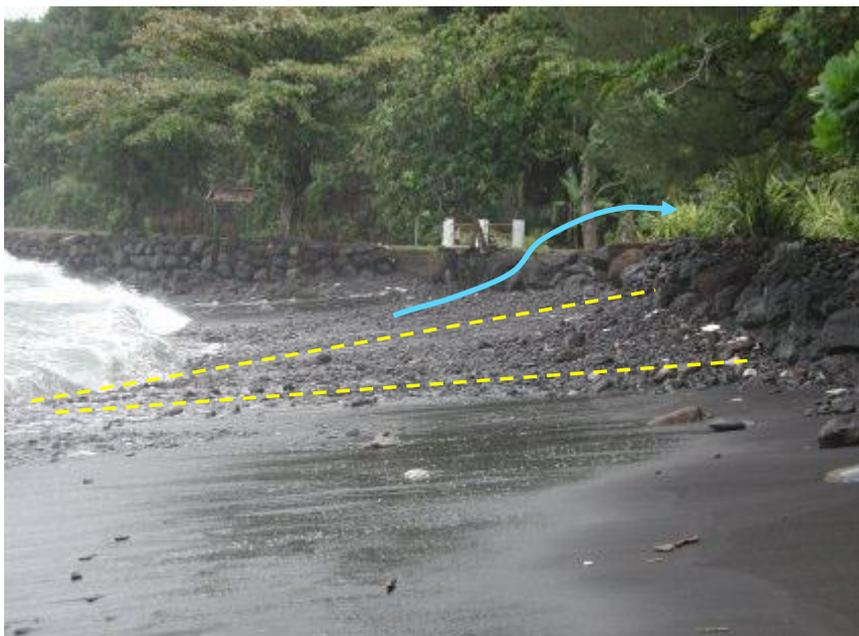
Figure 9 : Enrochement, remblai et route en haut de plage. Accumulation de galets (tirets jaunes) contre les enrochements protégeant la route dans le secteur de Vairao, lors d'une houle de 3-4 m de direction S-SW (Des Garets 2005). Ce prisme favorise le franchissement de l'ouvrage (symbolisé par la flèche bleue).
