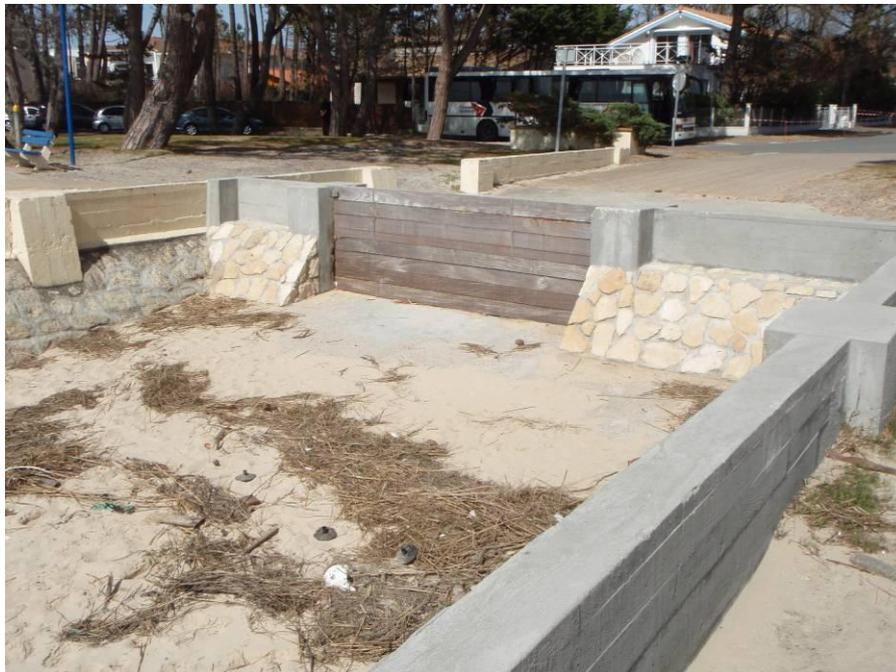
*Figure 39 : Réhausse de muret et fermeture provisoire d'accès à la plage par batardeau (Andernos-les-Bains, Photo Observatoire de la Côte Aquitaine)*
