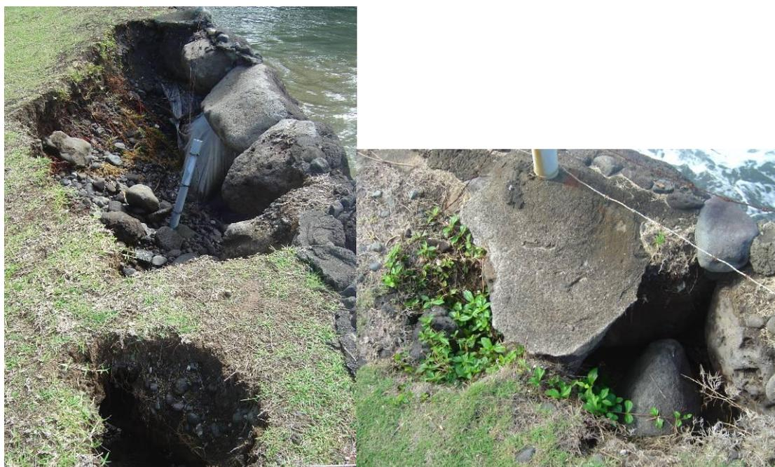
Figure 29 : Affouillement et érosion des remblais situés en arrière des enrochements par déferlement au-dessus de l'ouvrage (Parara, face à la passe de Rairoa, Ph. C. Chene)
