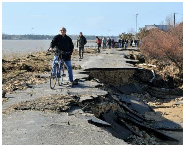
*Figure 35 : Brèches et fortes dégradations de la digue de l'Aiguillon lors de la tempête Xynthia (2010)*
