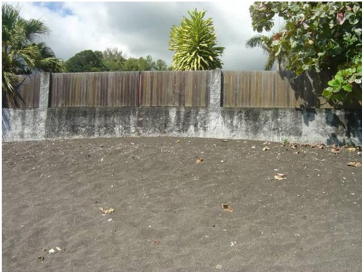
Figure 25 : Mur avec palissade en haut de plage sans remblai (ou faible épaisseur de remblai ; Arue, Commune d'Arue Aire de loisir Vaipoopoo, photo C. Chene)
