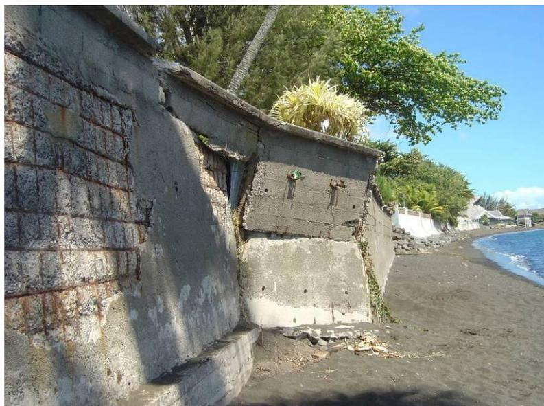
*Figure 31 : Très forte dégradation d'un mur béton en haut de plage (Pirae, Ph. C. Chene)*
