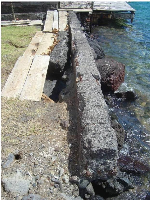
*Figure 30 : Très forte dégradation d'un muret en béton et affouillement des terrains en arrière de l'ouvrage (Pirae)*
