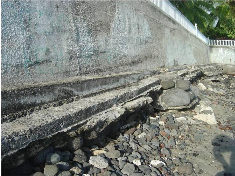
Figure 32 : Dégradation et déchaussement en haut de plage de la base d'un mur par érosion de la plage
