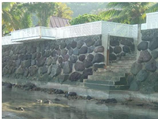
Figure 14 : Haut mur de bas de plage en enrochement cimenté avec balustrade, escalier et remblai (Commune de Paea, Ph . C. Chene)
