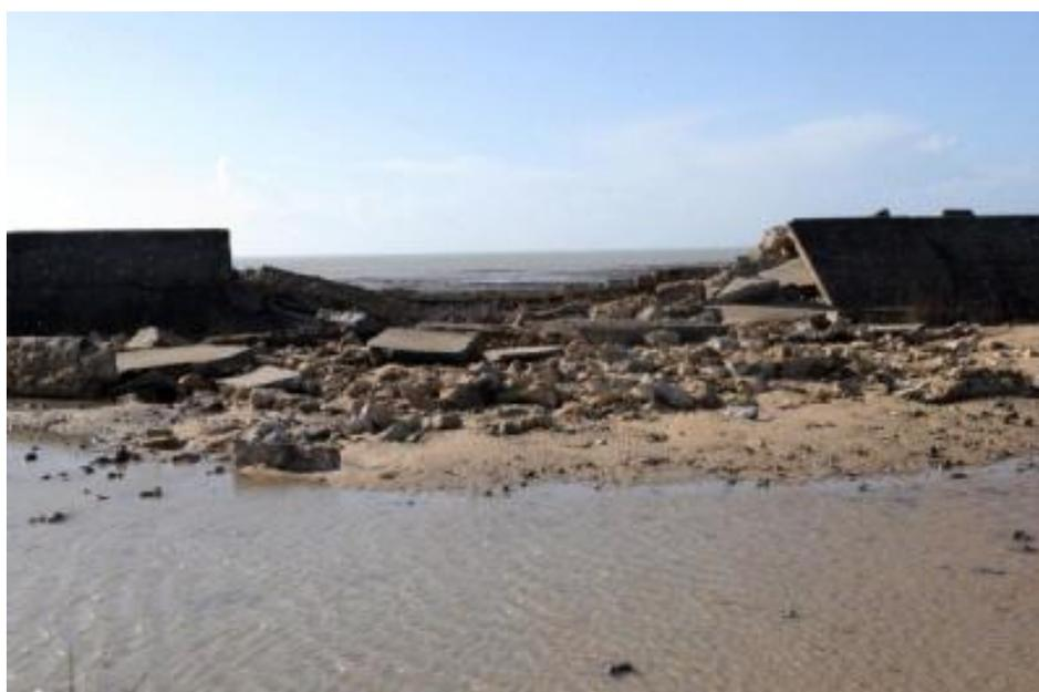
*Figure 34 : Brèches dans les digues suite au passage de la tempête Xynthia (2010) : brèche dans la digue marine du Marais de Guérande (haut), destruction d'une digue sur l'île de Ré (bas)*
