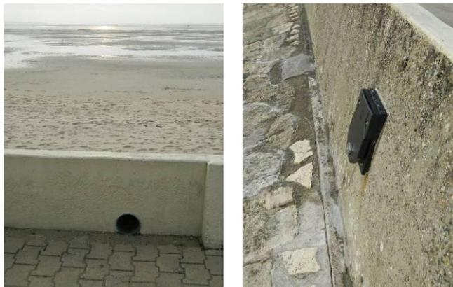
Figure 41 : Buse d'évacuation équipé d'un clapet anti-retour coté océan à Andernos-les-Bains (Photo Observatoire de la Côte Aquitaine)
