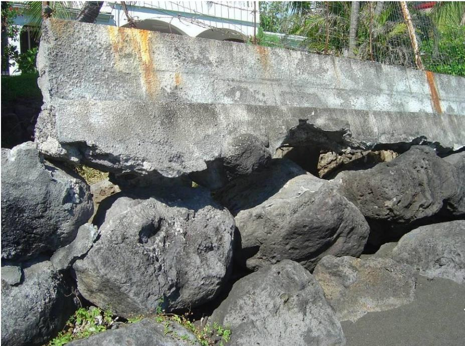
*Figure 27 :Exemple de dégradation et déchaussement d'aménagements par attaque de vague et érosion en haut de plage. Le manque d'entretien des aménagements compromet fortement leurs fonctions (Commune d' Arue, plage Lafayette, ph. C. Chene)*
