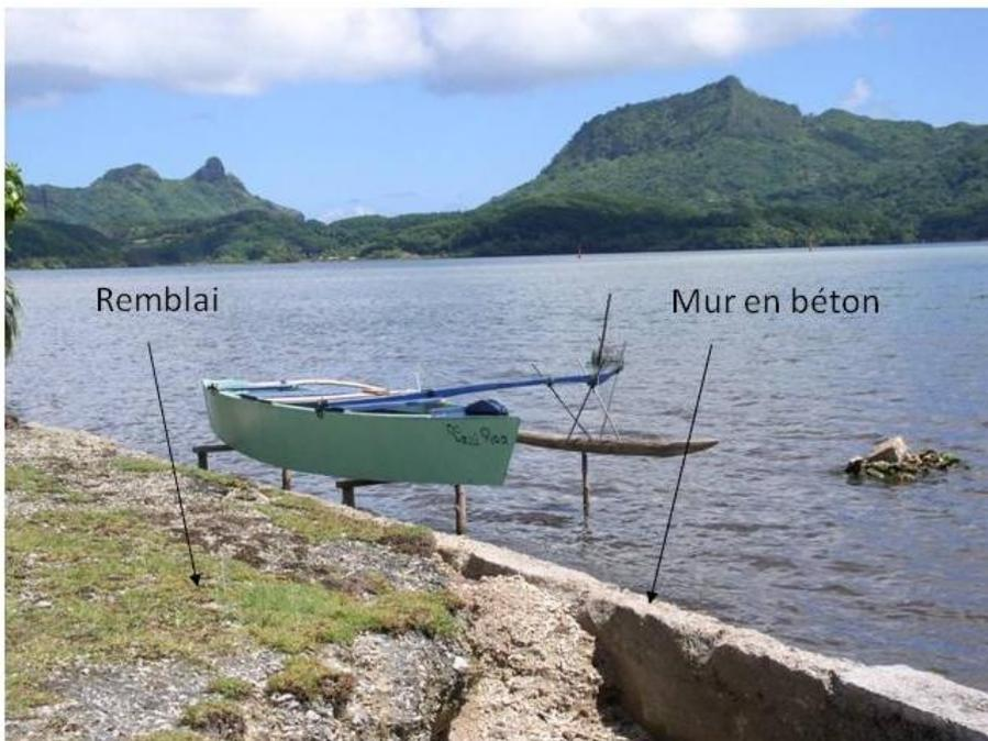
Figure 17 : Aménagement littoral public de petit fond en mur béton et remblai (Huahine 2006, Ph. M. Garcin) A noter les affouillements du remblai en arrière du mur en béton
