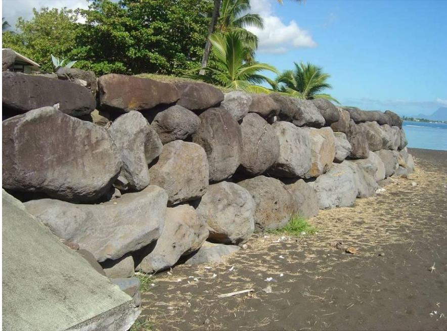
Figure 22 : Mur en enrochement de haut de plage avec remblai et enjeux en arrière (Commune d'Arue Plage Lafayette, photo C. Chene)
