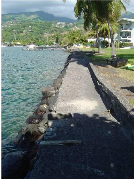
*Figure 15 : Petits enrochements de faible altitude avec promenade et muret sur remblai (Commune d' Arue, ph. C. Chene) La dégradation du muret est à noter*
