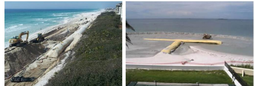
Illustration 11 - Exemple de structures en géotextiles longitudinal en pied de dune (à gauche) ou en épi en T (à droite).
