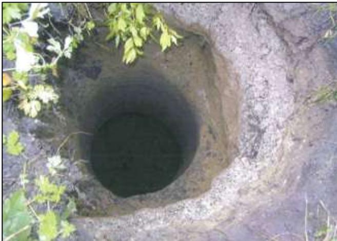
Figure 30 : Effondrement d'un bouchon de catiche sur la commune de Carvin (BRGM)
