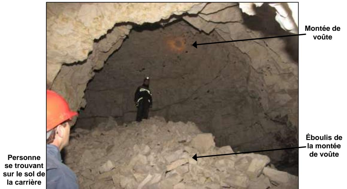
Figure 25 : Photo d'une cloche de fontis dans une carrière à Amiens (BRGM)
