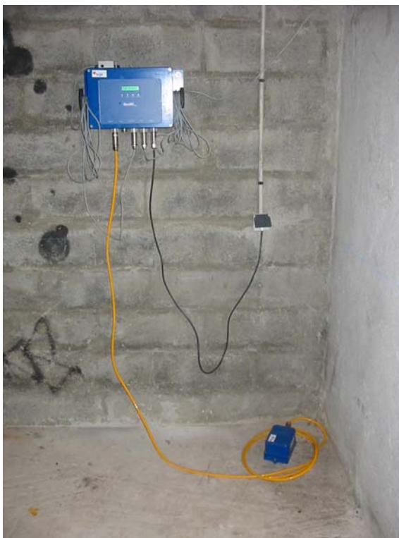
Figure 11 : Station de type GSR24. SAST à Sainte-Anne – Guadeloupe.
