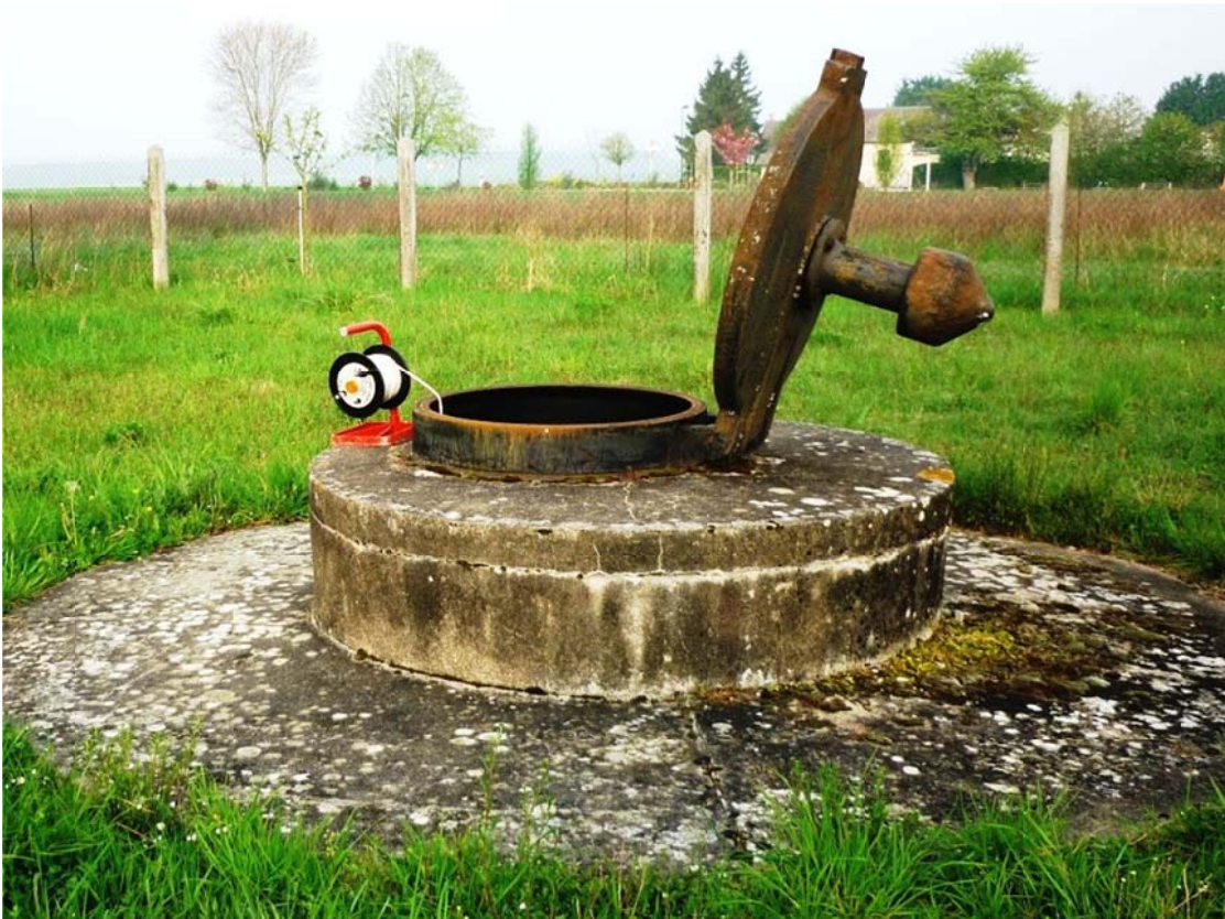
Illustration 20 : Tête de puits d'un captage AEP, département du Cher (cliché BRGM)
