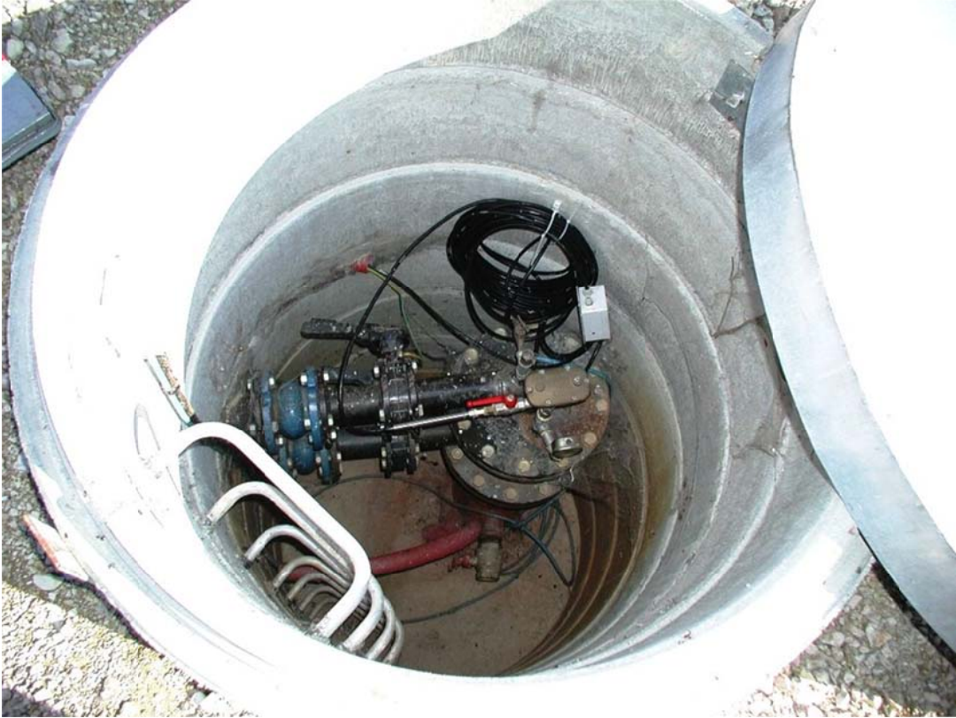
Illustration 21 : Branchements à la colonne d'exhaure d'un forage AEP (cliché BRGM)
