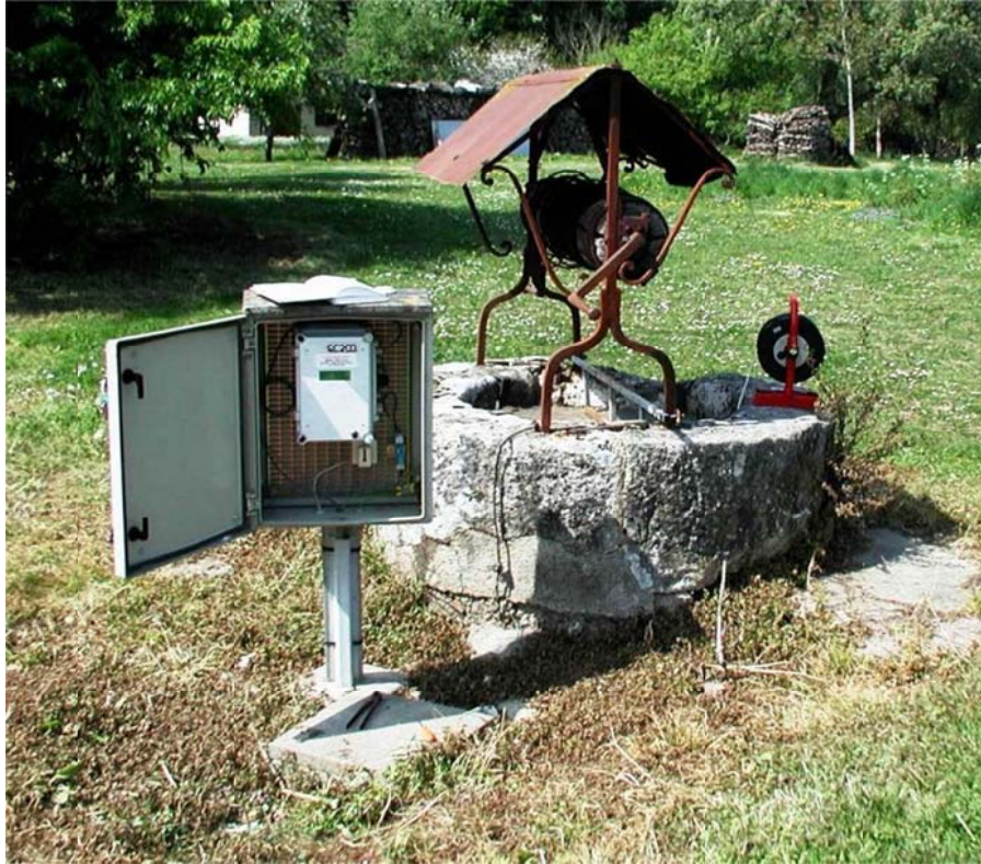
Illustration 16 : Photo d'un puits équipé d'une sonde et d'une centrale de mesure, dans le département du Cher (cliché BRGM)
