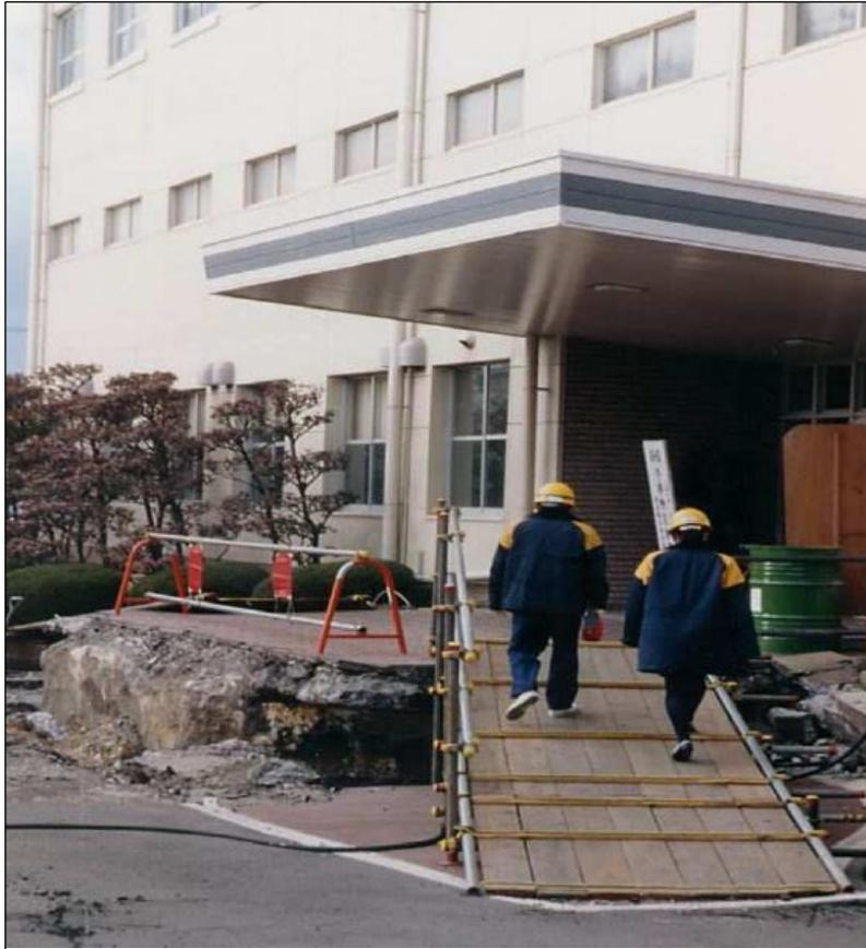
Figure 51 : Effet de la liquéfaction – Tassements : Kobe (Japon), séisme du 17/01/1995 (Magnitude 6.8)
