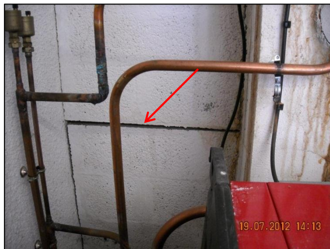
Figure 20 : Fissure ouverte sur le mur séparant la chaufferie du garage (côté chaufferie)
