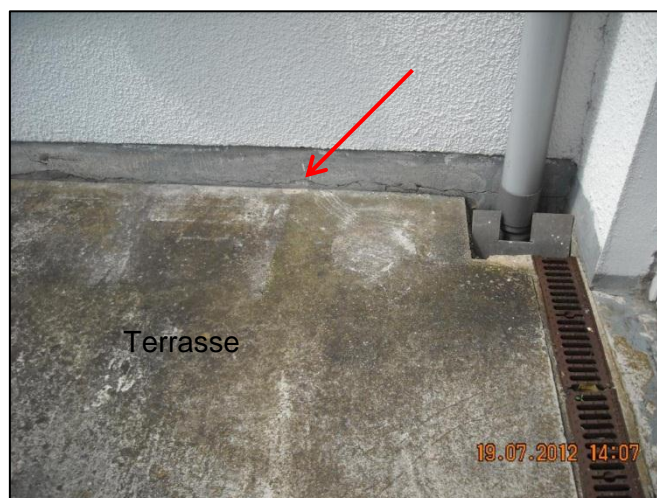
Figure 14 : Fissure horizontale en bas du mur sud-est de la maison
