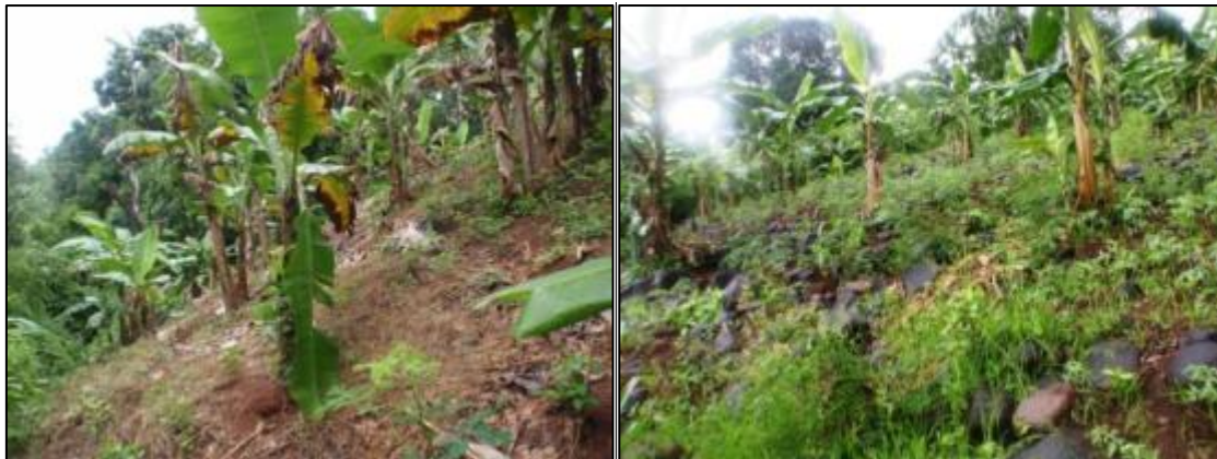
Figure 15 – Pentes fortes observées au droit du projet recouvertes de bananiers. A gauche, point A et à droite point B de la Figure 14.
