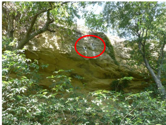
Illustration 5 : Boulons d'ancrage sur un surplomb
