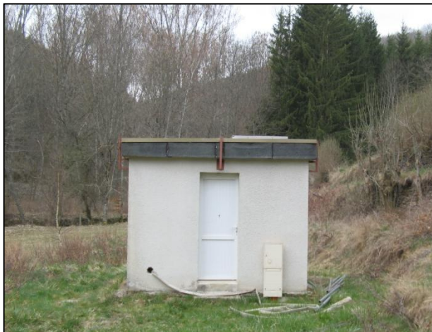
Illustration 28 : Local technique et périmètre sanitaire d'émergence du forage F6
