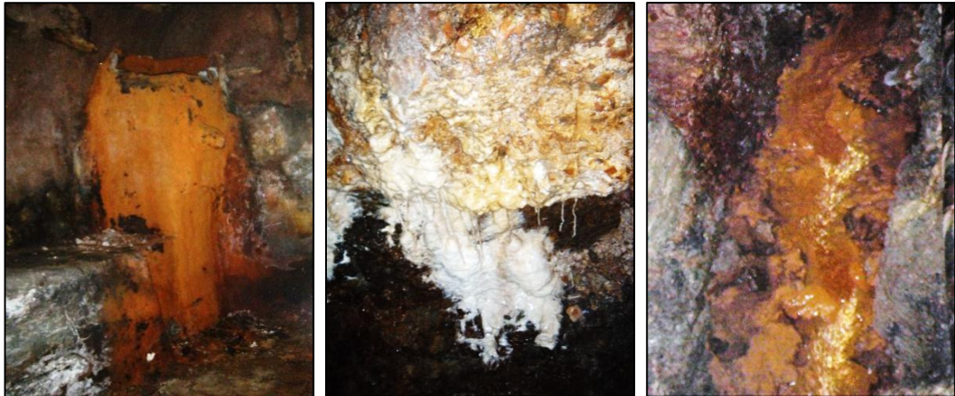
Illustration 32 : Dépôts d'oxydes de fer et autres minéralisations dans la galerie du préfet
