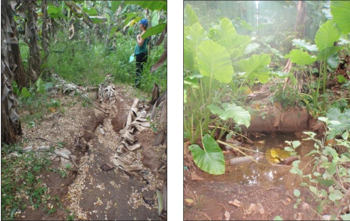
Figure 8 – A gauche, traces de ravinement produites par les eaux évacuées du collège. A droite, deuxième bouche d'évacuation des eaux du collège (point C de la Figure 6).
