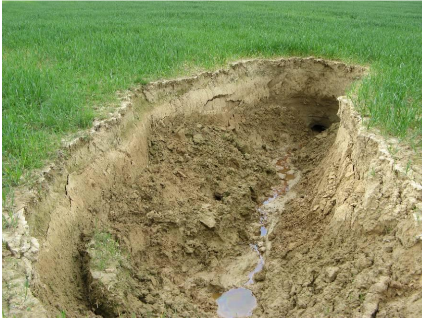
Illustration 6 – 1 er Effondrement (vue direction Nord, dans le sens naturel de la pente (Source : BRGM).
