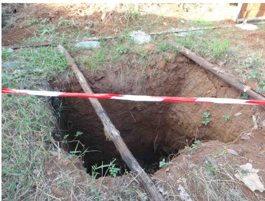
Illustration 19 - vue du puits (Nord : en haut).
