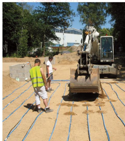
Pose de l'échangeur instrumenté de la plate-forme BRGM
