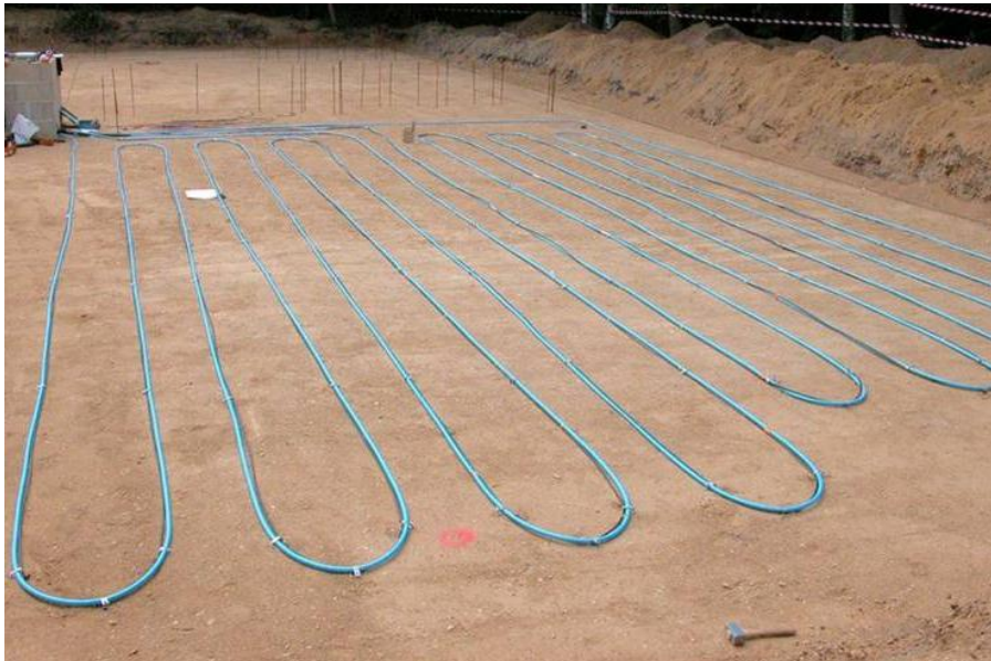
Figure 4 - Vue des tubes de l'échangeur lors de leurs mises en places sur un des quatre cadrans de la zone d'implantation des échangeurs géothermiques horizontaux.
