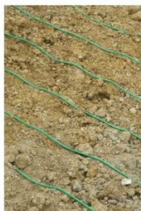
Pose de l'échangeur instrumenté de la plate-forme BRGM
