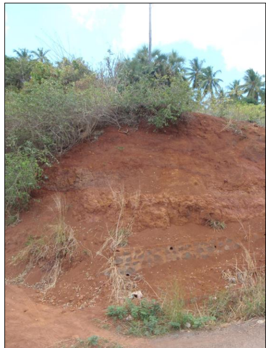
Illustration 9. Butte instable en bordure de voirie au sein de la zone d'étude. Photo BRGM
