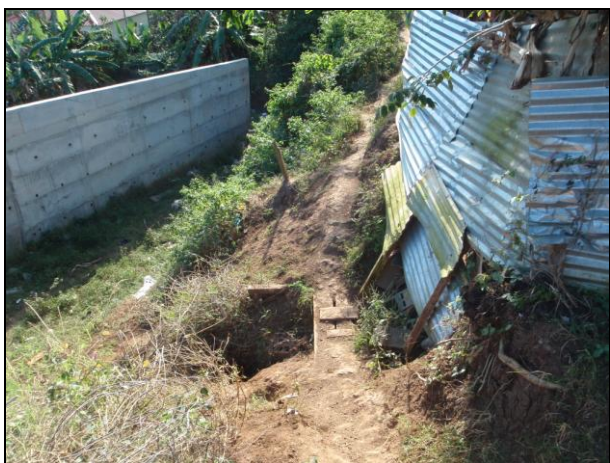
Illustration 5. Différents points de rejets d'eaux usées et pluviales en tête du talus
