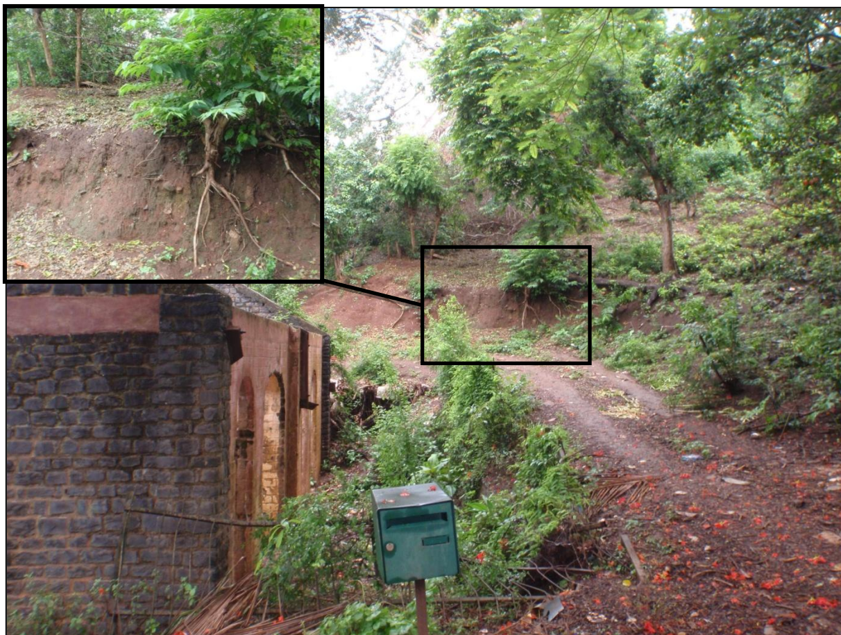
Illustration 6 – Limite Nord du projet, la zone encadrée correspond à un terrassement sauvage, laissant affleurer des colluvions. Photos BRGM.
