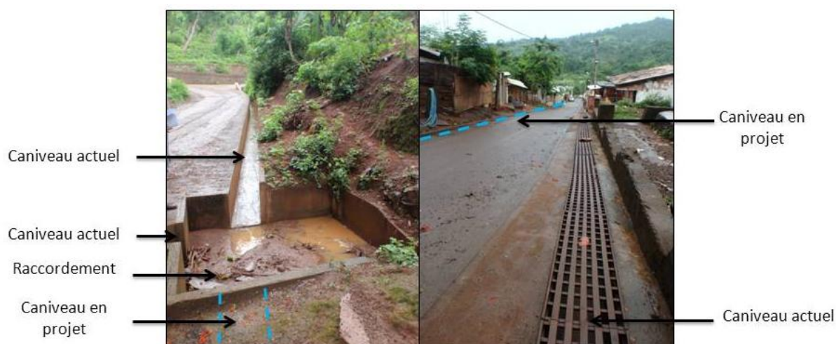
Illustration 10 – Aménagements hydrauliques actuels et futurs (tiretés bleus) sur la zone d'étude. A gauche, zone amont du projet avec le point de raccordement des caniveaux. A droite, caniveau actuel longeant le projet. Photos BRGM.
