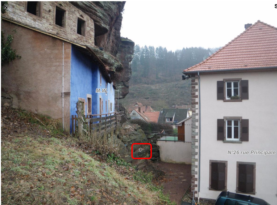
Illustration 5 : Extrémité ouest des troglodytes, la maison Wagner (M.W.) à gauche surplombant le bâtiment communal
