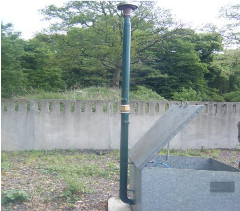
Illustration 13 - Sondage S34 à Raismes (59), concession renoncée de Vicoigne, équipé d'un pare-flamme de type AMAL.
