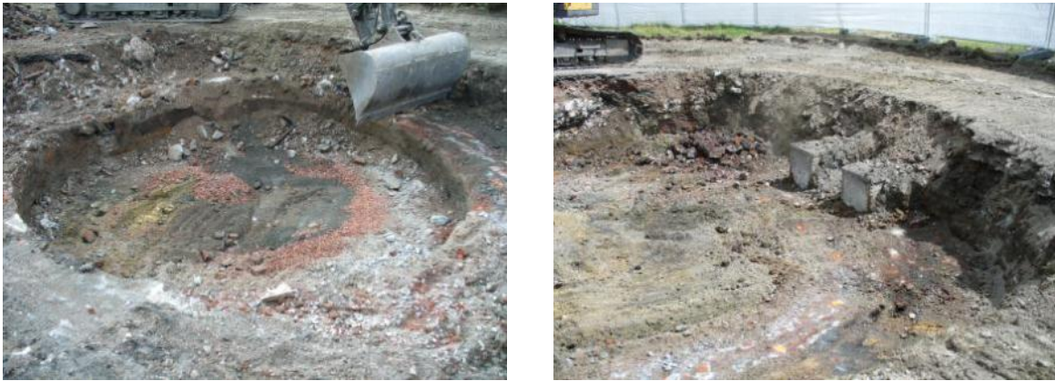
Illustration 29 - Dégagement de la tête du puits 4.
