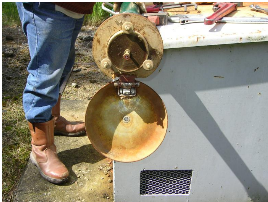
Illustration 16 - Sondage 05 à Raismes (59), concession renoncée de Vicoigne - Nettoyage de pare-flammes.
