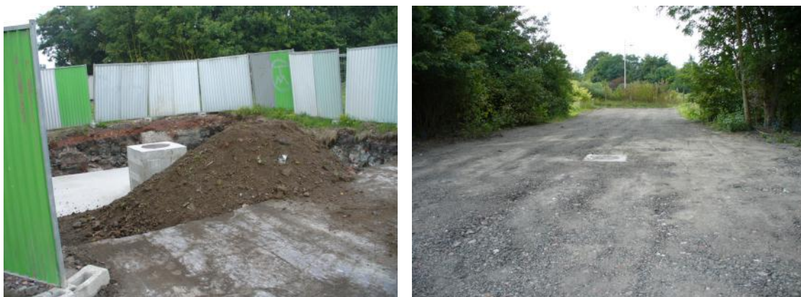
Illustration 33 - Cheminée béton et son équipement de contrôle.
