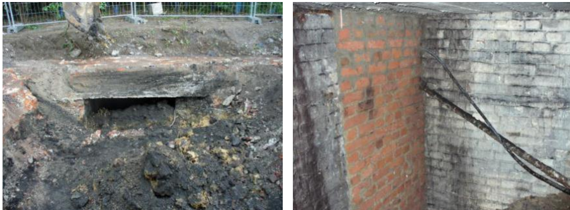
Illustration 26 - Galerie technique en tête du puits 11 découverte lors des travaux.
