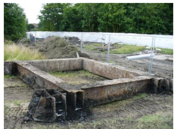
Illustration 24 - Châssis métallique de l'ancienne dalle du puits 11 de Sallaumines (62), travaux 2011.
