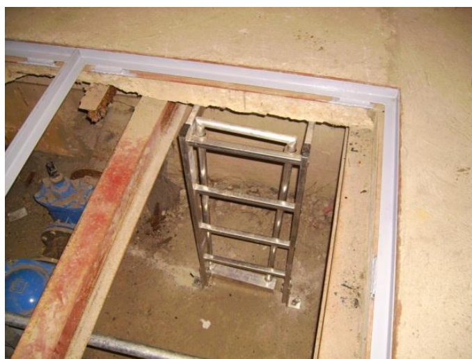
Illustration 9 - Mise en sécurité de la station de relevage Intermarché (Marles-les-Mines, 62).
