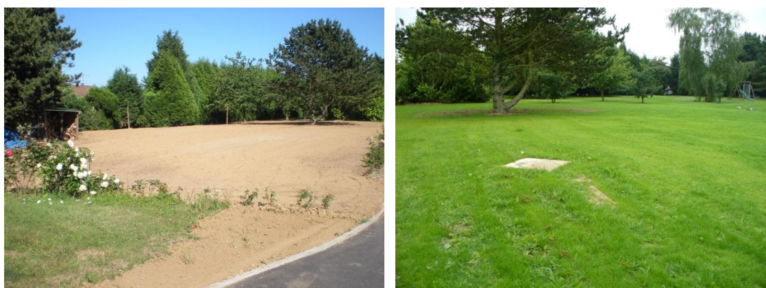
Illustration 22 - Végétalisation de l'emprise des travaux sur le puits d'Annezin (62).
