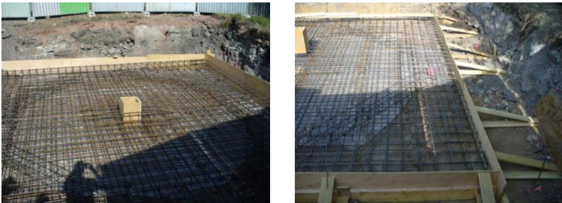
Illustration 30 - Coffrage et ferrailage des dalles de puits.
