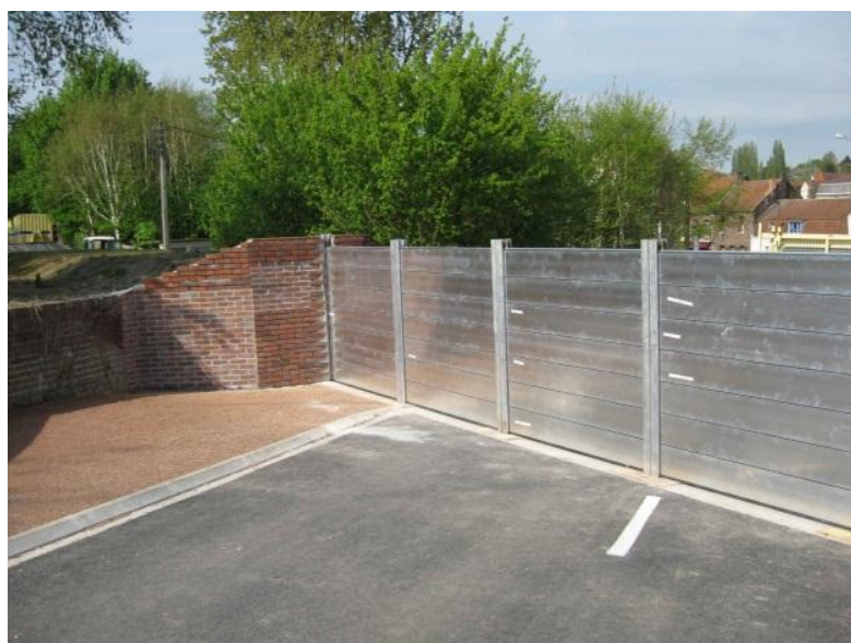
Illustration 11 - Exercice de mise en place des batardeaux (Bruay-la-Buissière, 62).
