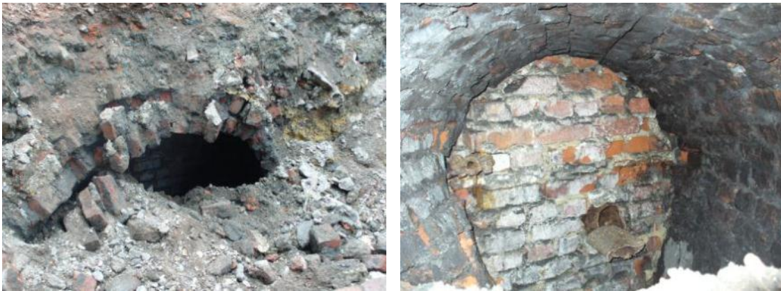
Illustration 28 - Niches en tête du puits 11 découvertes lors des travaux.
