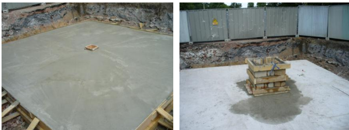
Illustration 31 - Préparation cheminée béton pour équipements de contrôle.
