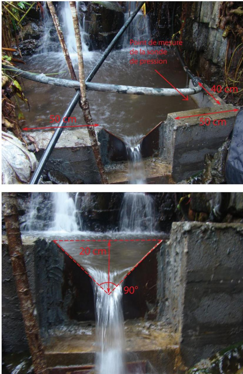
Figure 26 : Caractéristiques du seuil Bielle 2
