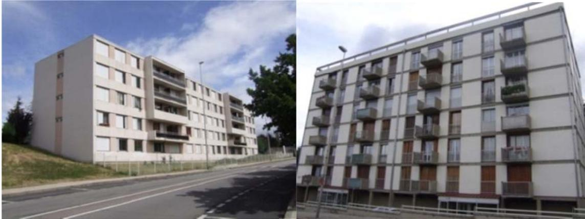
Figure 21 - Bâtiments de type HLM : le bâtiment à droite présente une transparence du RDC (photos BRGM)
