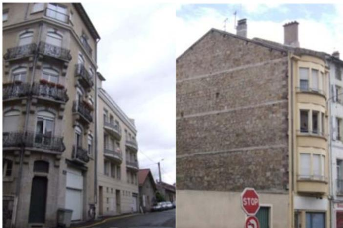
Figure 19 - Bâtiments d'habitat collectif avec des murs porteurs en pierres (photos BRGM) :
