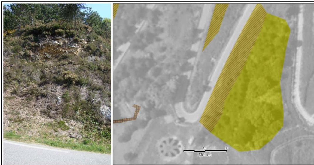
Illustration 19 : Versant avec un aléa chute de blocs faible et un aléa chute de pierres moyen (montagne du Roule, Cherbourg)
