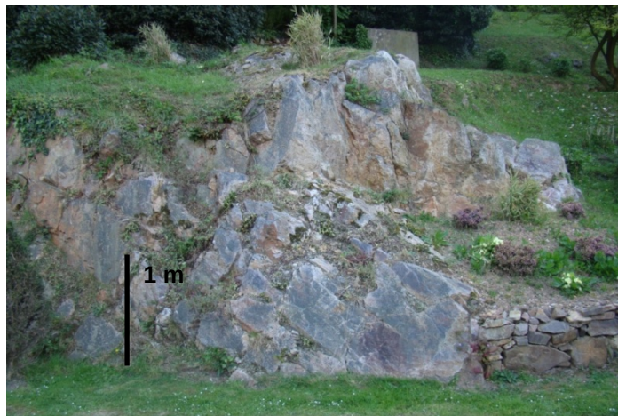
Illustration 17 : Exemple de site où le relevé de fracturation a donné un aléa fort alors que la hauteur est inférieure à 3 m (2,5 m). L'aléa a été ramené à faible. Affleurement situé à Cherbourg, rue des Vosges.
