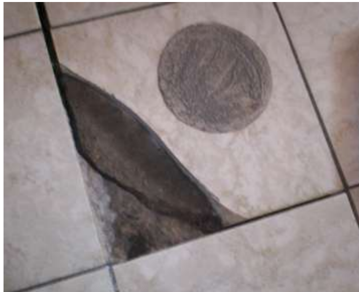
Figure 22 : Vue de la dalle sous un carrelage, à l'endroit d'un sondage géotechnique effectué en 2009.
