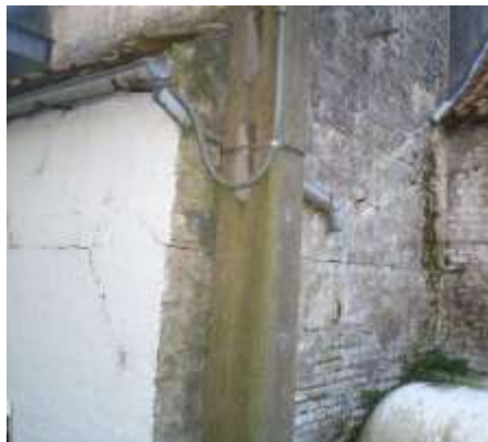
Figure 10 : Fissures affectant les quatre façades de la Maison d'habitation. a) Pignon est ; b) véranda accolé à la façade nord ; c) façade nord et ouest ; d) seuil de la porte fenêtré du salon, côté sud
