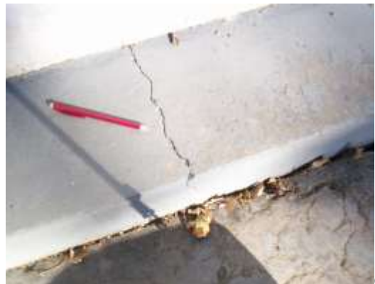
Figure 10 : Fissures affectant les quatre façades de la Maison d'habitation. a) Pignon est ; b) véranda accolé à la façade nord ; c) façade nord et ouest ; d) seuil de la porte fenêtré du salon, côté sud
