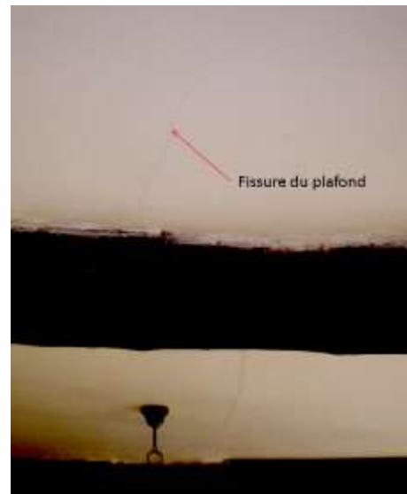
Figure 11 : Dommages observés à l'intérieur de l'Habitation principale a) Fissure traversante de la façade nord, et infiltrations au niveau de la cage d'escalier ; b) Infiltrations dans une chambre de l'étage ; c) Fissures et déplacement de cloisons dans une chambre de l'étage ; d) Fissure au plafond du salon (rez-de-chaussée) récemment revêtu de papier peint
