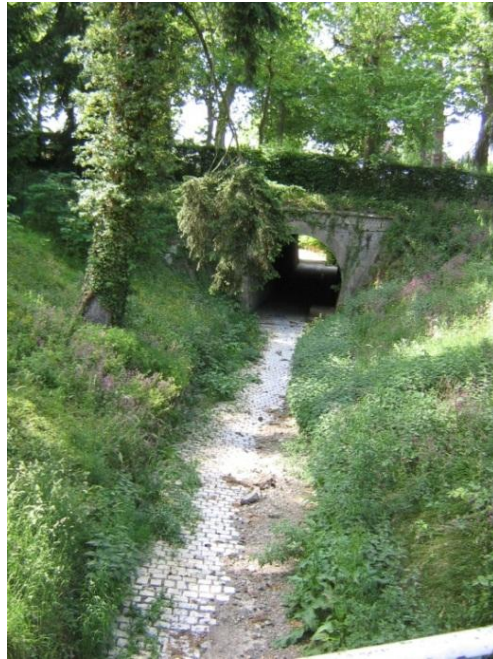
Illustration 18 : Lit du ruisseau temporaire Le Borne (à environ 30 m du nouveau forage)
