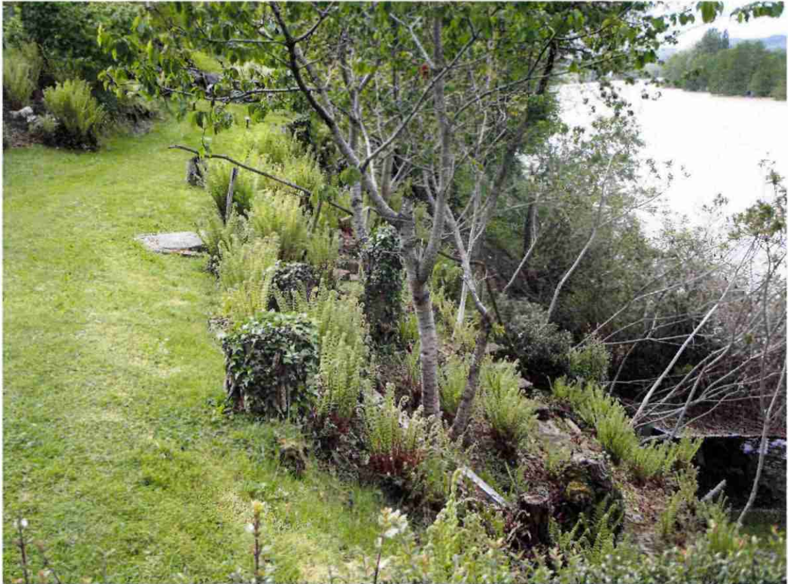
Illustration 18 : Erosion de berge sur la commune de St Livrade (Lot et Garonne).
