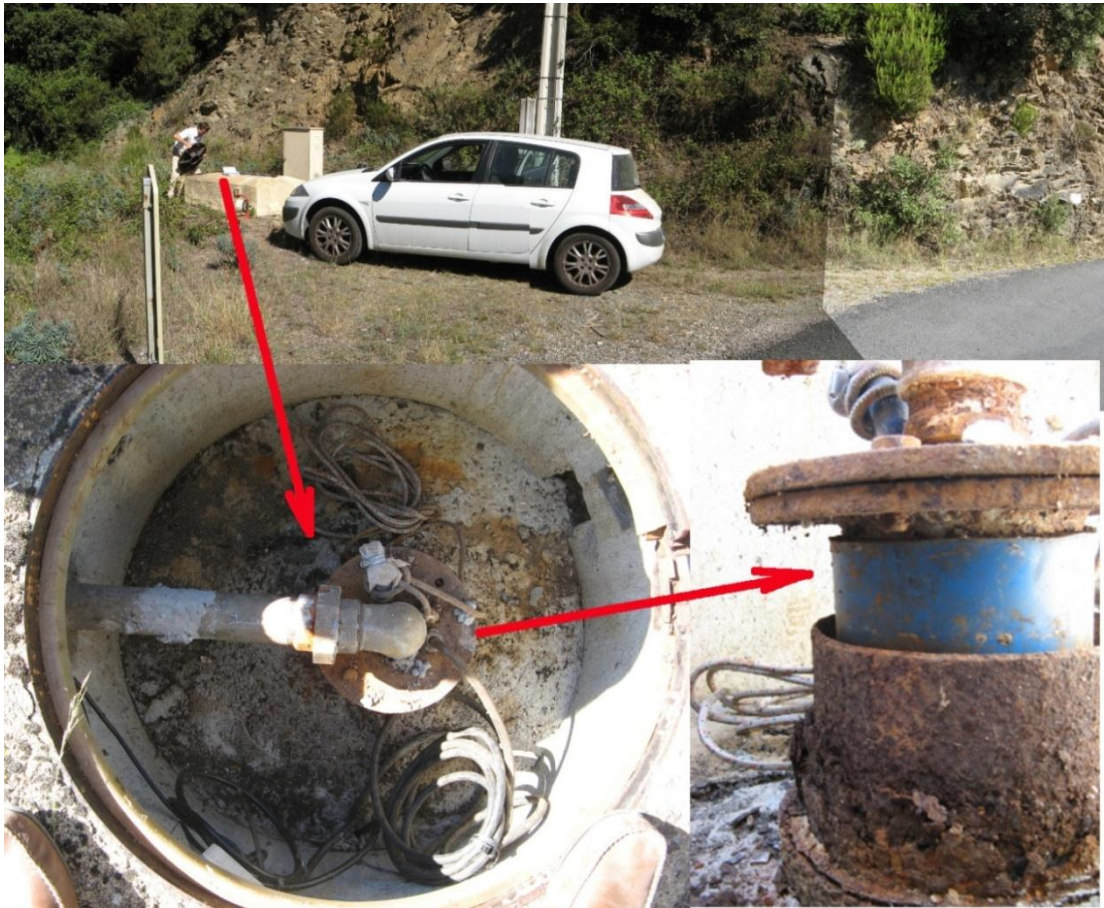
Illustration 4 : Vues de la position du forage de Font-Couverte par rapport à la route (haut), de l'état du forage vu du haut (bas-gauche) et de côté (bas-droite).
