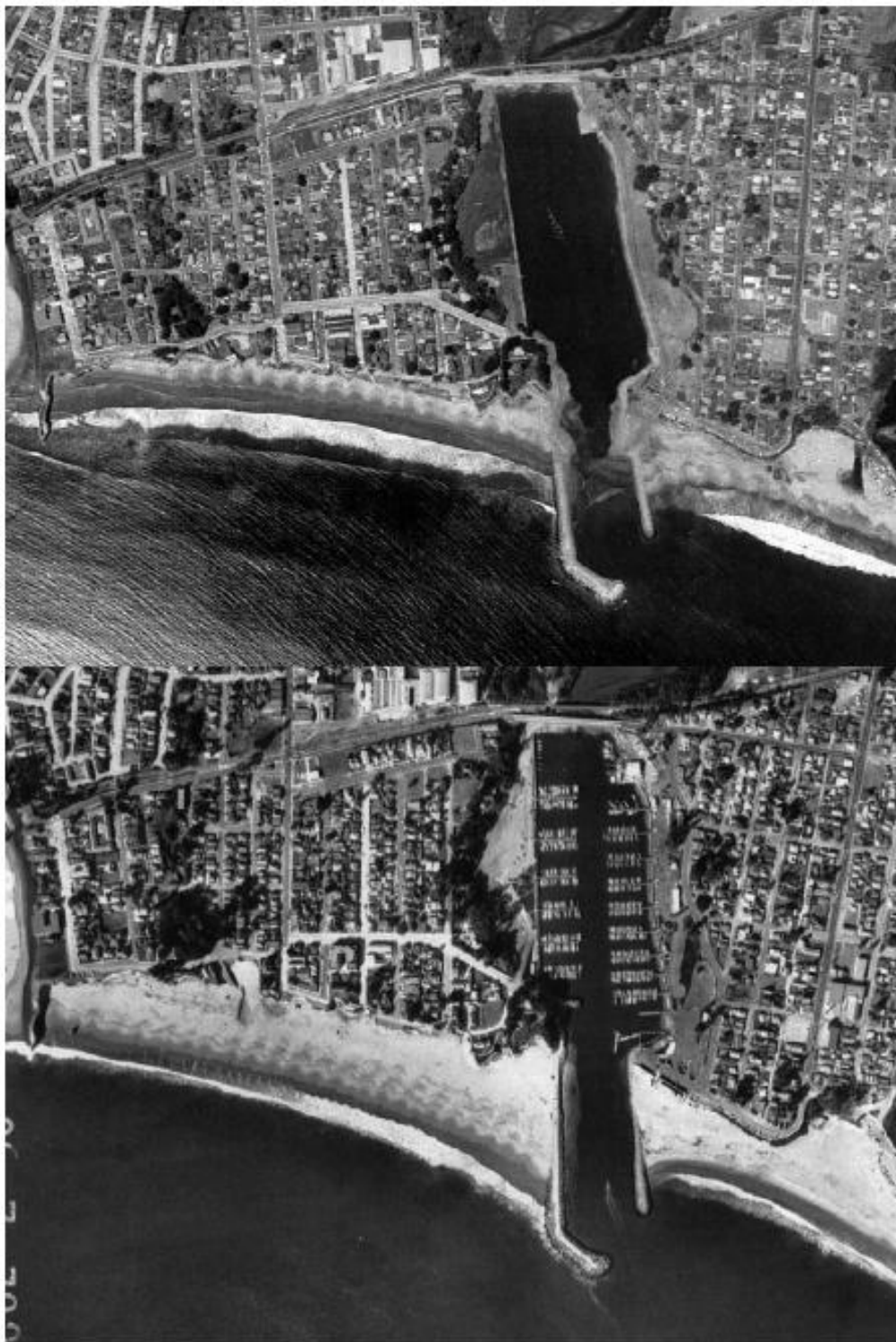
Figure 20: Un exemple de l'impact des jetées à Santa Cruz Yacht Harbor en 1963 (haut), une année après la construction des jetées, et en 1987 (bas), plus de 20 ans après la construction, démontrant l'accumulation de sédiments en amont des jetées [source : Hapke et al. (2006)].
