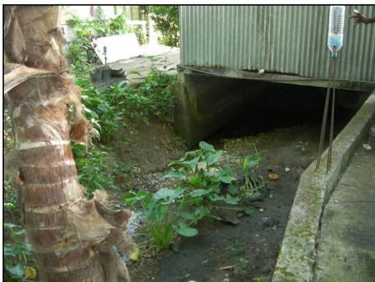
**ID 01** : RN5 Sud-ouest Bosrédon, proximité station Total – vue d'une ravine bordée d'habitations ; ouvrage hydraulique causant une réduction de la section d'écoulement des eaux
