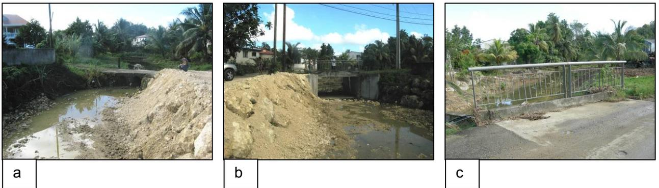
**ID 35** : Nord Doubs, à l'aval de l'accident – Succession de deux ouvrages de franchissement sous dimensionnés compte tenu des débits mis en jeu. a) 1<sup>er</sup> ouvrage (accès à habitats), vue aval, b) 2<sup>ème</sup> ouvrage vue amont, c) laisses de crues sur les garde-corps du 2<sup>ème</sup> ouvrage. Les berges présentent une instabilité réelle et la sinuosité de ce canal favorise encore les débordements en cas de crue.
