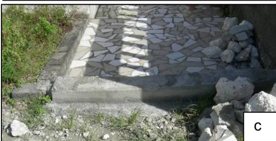
**ID 11** : D 107, lieu-dit Blain, station Total- zone fréquemment inondée durant les intempéries en raison du sous-dimensionnement de l'ouvrage hydraulique et du mauvais drainage des eaux pluviales : a) section transversale, b) partie aval avec une réduction notable de la section d'écoulement par les habitations encadrant le canal. c) stratégie d'un particulier visant à rehausser le niveau du sol de son habitation en prévention des inondations
