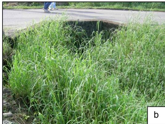
**ID 07** : Chemin de Perrin, Sud Chevalier, proche D106 – vue de la zone amont de l’ouvrage, b) vue aval ; débordement de la ravine sur route en ce point lié au sous-dimensionnement de l’ouvrage de franchissement et au manque d’entretien visible de la ravine.
