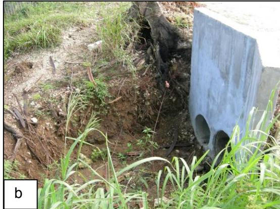
**ID 28** : Canal des Rotours proche Lotissement Rousseau les Manguiers - Inondation du lotissement en rive droite du canal. Problème de la mise en charge du canal des Rotours créant une inversion du sens d'écoulement dans le chenal perpendiculaire en rive droite normalement drainé par ce canal. a) vue de l'ouvrage partie aval, b) buses avales
