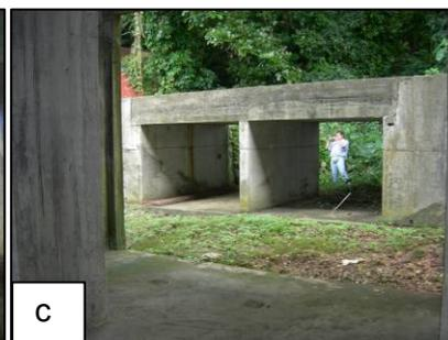
**ID 31** : proximité carrefour D101 avec D108 - Habitats construits dans le lit de la ravine dont un placé directement à l'aval d'un ouvrage à dalots (dimensionnement correct) constituant une entrave importante à l'écoulement naturel des eaux. Danger réel pour les habitants ; a) vue de l'ouvrage en section et de l'habitat en construction placé à l'aval, b) vue de l'aval en amont de l'ouvrage, c) vue aval de l'ouvrage.
