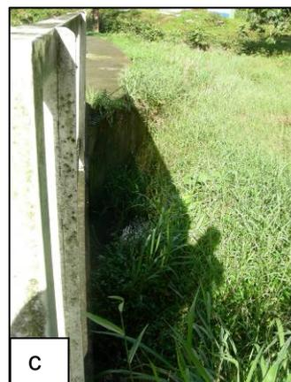
**ID 52** : route vers Port Blanc – a) pont de franchissement, b) embâcle au niveau du pont en amont, c) vue avale de l'ouvrage. Route coupée en discontinu sur tout cet axe routier - 1ère coupure allant de cet ouvrage au pont suivant à l'aval sur 500 m environ (direction N4) puis deuxième coupure à environ 1 km à l'aval - mise en cause partielle du busage sous dimensionné des ouvrages.
