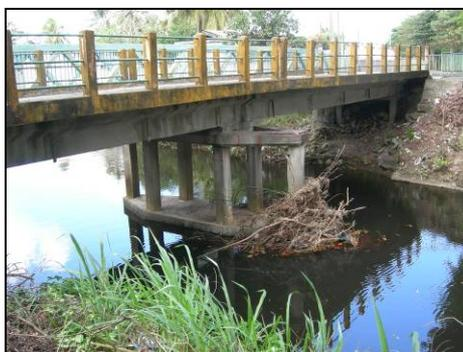
**ID 25** : Pont canal des Retours, Nord Bourg - embâcle au niveau du pont, dimensionnement correct, influence probable de la marée sur l'ouvrage, des systèmes de clapets peuvent être envisagés.
