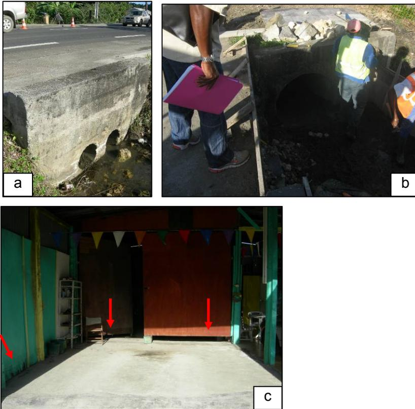
**ID 00** : RN5 Sud-ouest Bosrédon, proximité station Total - Route coupée et habitations alentours inondées – a) amont et b) aval : mise en cause de l'ouvrage d'évacuation des eaux pluviales (sous-dimensionnement des 2 buses en amont de l'ouvrage) – c) laisses de crue dans une habitation en contrebas
