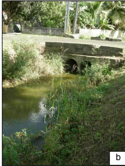
**ID 04** : Belle Espérance, WSW Bosrédon – a) amont, b) aval : ouvrage sous-dimensionné au regard de l'événement de janvier – zone résidentielle (lotissement) inondée et empêchant l'infiltration par imperméabilisation du substrat ; accroissement du ruissellement.
