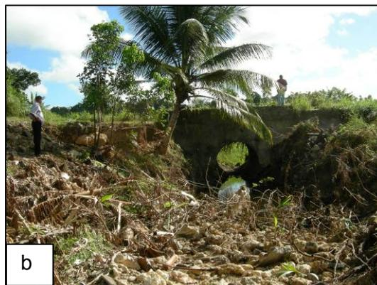
**ID 37** : Est D126, Sud Caduc - ouvrage de franchissement ayant subi d'importants dommages durant la crue - Blocs à l'aval risquant d'être remobilisés sous l'action d'une nouvelle crue – curage de la ravine nécessaire + expertise technique de l'ouvrage en question. a) section, b) vue aval du pont.
