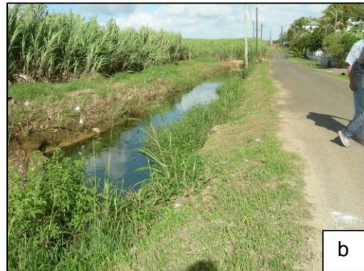
**ID 05** : Belle Espérance - WSW Bosrédon - Problématique de l'ouvrage d'évacuation sous-dimensionné au droit de cette portion de route : a) vue amont, b) vue avale ; canal (affluent de celui de Perrin) formant un angle à 90° à l'aval de l'ouvrage et gênant l'écoulement naturel ; curage récent de la ravine mais stockage des sédiments à proximité d'où un re-dépôt dans la ravine ; zone agricole en cours d'urbanisation, à verrouiller impérativement en zone tampon.
