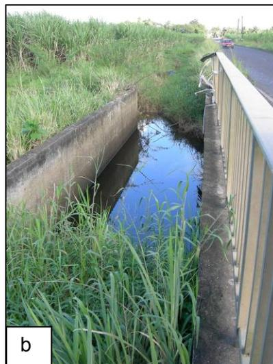
**ID 38 :** D106 Pont Colcongue sur Petite Rivière – a) pont submergé durant les inondations de janvier, route coupée sur 200 m avec hauteur d'eau supérieure à 0,50 m ; sous-dimensionnement de l'ouvrage au droit de cette portion de route, garde-corps dégradés – b) mur de soutènement de la berge en rive gauche disposé perpendiculairement à la direction d'écoulement : écueil à l'écoulement naturel des eaux.
