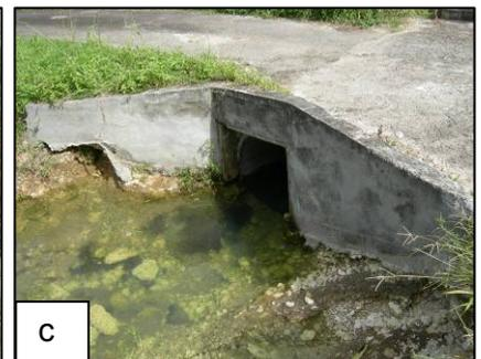
**ID 40 :** D101 entre Doubs et Chazeau - succession de deux ouvrages en série (a) visiblement sous-dimensionnés – débordement signalé sur la chaussée avec route inondée sur 300 m de part et d'autre du point de référence – ravine également très sous-dimensionnée pour assurer l'évacuation des eaux ruisselées. b) vue amont du 1<sup>er</sup> ouvrage avec quelques laisses de crues, c) vue aval du 2<sup>ème</sup> ouvrage.
