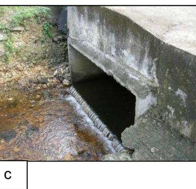
**ID 54** : Sud N4 - Belle Plaine - Zone particulièrement sensible au risque inondation : zone topographique basse et réceptacle des cours d'eau amont - système optimal de drainage à prévoir + zone tampon - 3 ouvrages successifs à recalibrer au droit cette la route. a) zoom sur l'un des ouvrages hydrauliques, b) vue de l'amont, c) vue de l'aval.
