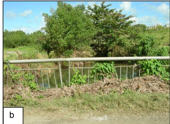
**ID 39 :** Pont Colcongue sur Canal de Perrin proche littoral - Dernier pont avant la mer, submergé durant la crue et en cours d'étude pour redimensionnement. a) amont de l'ouvrage avec laisses de crue au premier plan, b) garde-corps aval toujours avec des laisses de crue. Problématique portant sur la surface de la section d'écoulement du canal de Perrin trop étroite accentuée par des dépôts sédimentaires importants dans le lit.
