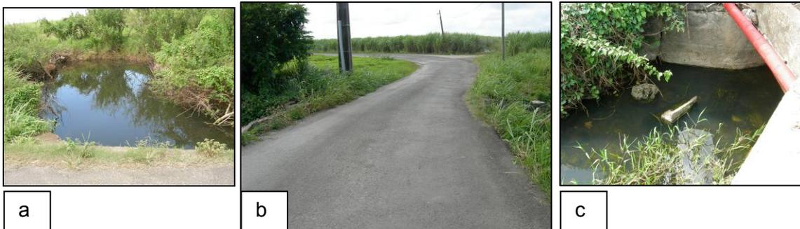
**ID 24** : Plaine de Grippon, Ravine des Coudes - sous dimensionnement du pont l'installation de garde-corps est préconisée pour matérialiser l'ouvrage et protéger les usagers. a) vue amont, b) section, c) vue aval
