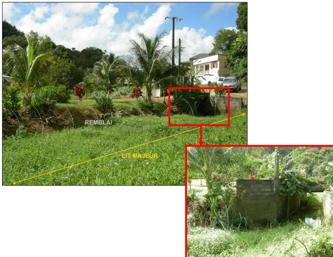
*Illustration 18 : ID 41 - exemple de remblaiement du lit majeur d'un cours d'eau sur la commune des Abymes (Grands-Fonds) couplé à la construction d'un ouvrage à accès à habitation sur lit mineur (BRGM)*
