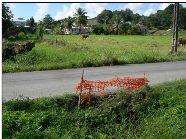
**ID 09** : Chemin de Naud, Quirine – ouvrage d’évacuation des eaux très sous-dimensionné avec passage à gué durant les inondations ; cette partie du territoire peu urbanisée et située à l’amont de la D 106 doit être verrouillée come zone tampon d’infiltration des eaux précipitées.
