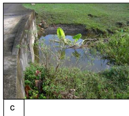
**ID 53** : D103 – Goudenave – Débordement (passage à gué) lié aux fortes précipitations en amont de cette zone + sous-dimensionnement apparent de l'ouvrage construit sur la ravine. a) vue de l'ouvrage, b) amont, c) aval.
