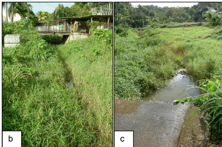
**ID 50** : Sud D103, lieu-dit Chauvel – débordement de la ravine en ce point ; mise en cause du sous-dimensionnement de l'ouvrage et des buses notamment. a) vue amont de l'ouvrage, b) vue de la ravine en amont de l'ouvrage, c) vue de la zone aval.
