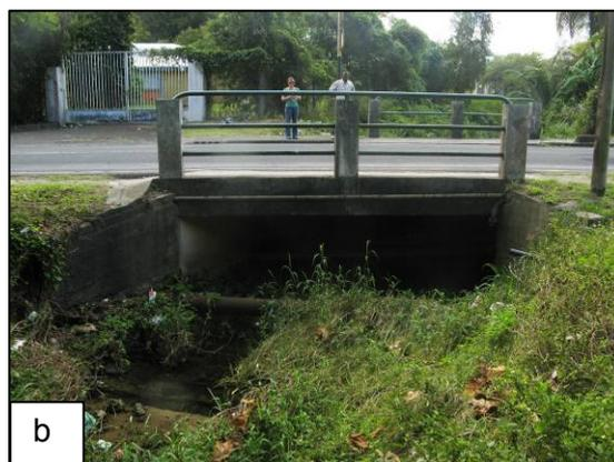
**ID 23** : Aval Darthres sur RN5 - Formation d'un embâcle (a) au niveau de l'ouvrage de franchissement du chenal sur RN 5 ; lame d'eau ? sur la chaussée insuffisante pour stopper la circulation. b) vue de l'aval Un curage du cours d'eau semble nécessaire jusqu'à la Ravine des Coudes.
