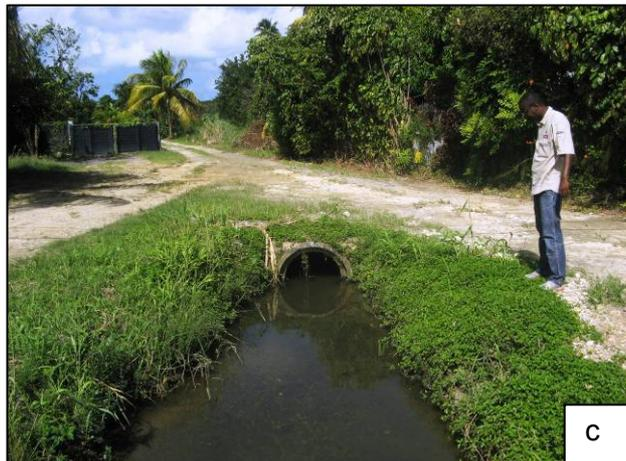
**ID 17** : Marieulle, sur RN5 – point noir du réseau routier régulièrement inondé en cas d'intempérie. Succession de deux ouvrages hydrauliques en charge et tout particulièrement sous-dimensionnés au droit de cette portion de route : a) vue amont du 1<sup>er</sup> ouvrage, b) vue aval du 1<sup>er</sup> ouvrage, c) vue amont du 2<sup>ème</sup> ouvrage.
