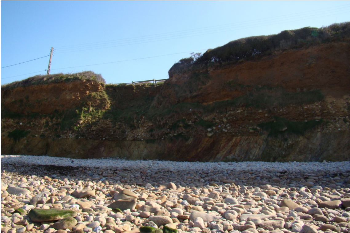
Photo 5 : Zone d'éboulement pour laquelle le BRGM est intervenu précédemment
