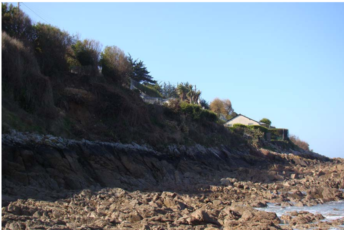
Photo 6 : Vue générale du site
