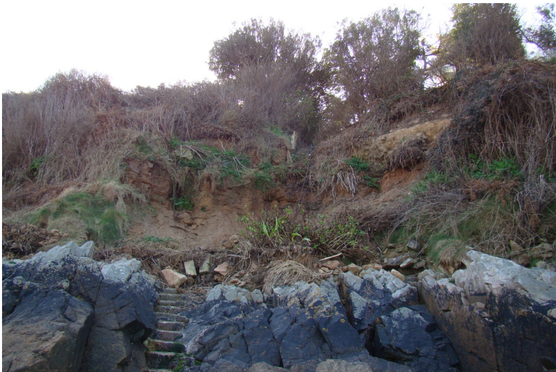
Photo 2 : Vue du glissement avec les dernières marches de l'escalier
