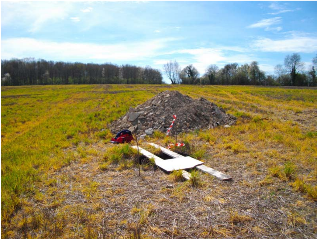
Photo 1 : Vue de l'effondrement.
