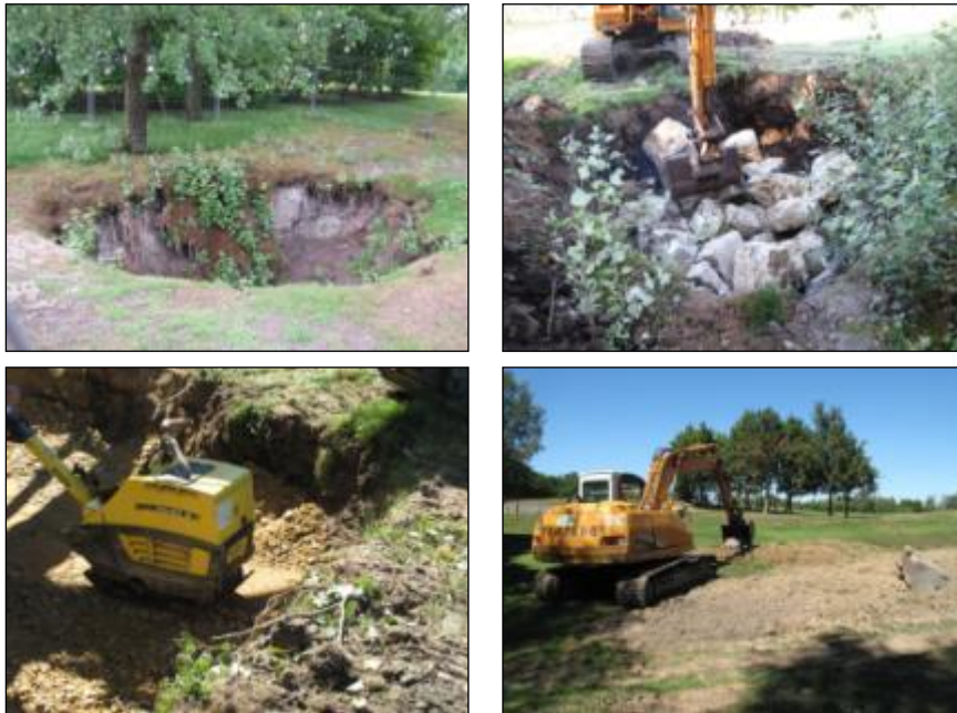
Illustration 159 - Fontis du golf de Montceau : avant - pendant les travaux, Montceau-les-Mines (71).
