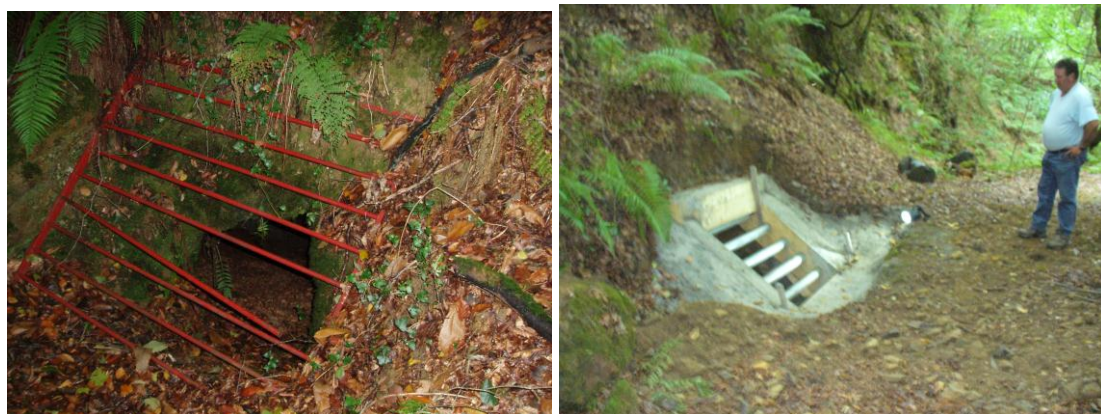
Illustration 146 - « Le Pas » - Entrée de la galerie (avant - après travaux) à L'Hermitage-Lorge (22).
