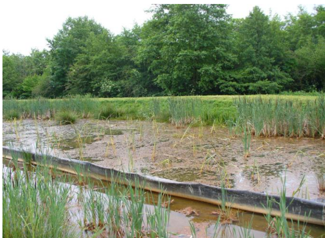
Illustration 6 - Station de traitement des eaux, roseaux fraîchement plantés, Buxières-les-Mines (03).
