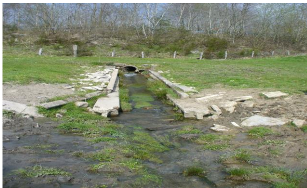
Illustration 11 - Lac des Fouthiaux : exutoire vers le ruisseau du Moulin Neuf, Sauvigny-les-Mines (71).
