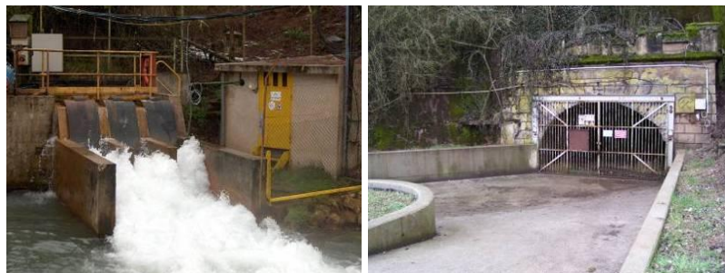
Illustration 21 - Surverse du bassin de pompage – Sortie Galerie de la Paix.
