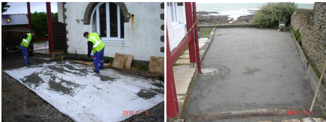
Illustration 181 - Fontis : Pose du géotextile - vue de la cour après travaux, Piriac-sur-Mer (44).
