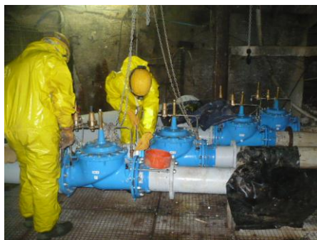
Illustration 13 - Montage d'éléments hydrauliques au Puits Gérard, commune de Mimet (13).
