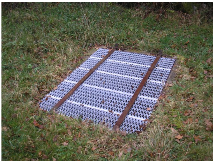
Illustration 15 - Grille de protection sur émergence « Les Rieux » à Roche-la-Molière (42).
