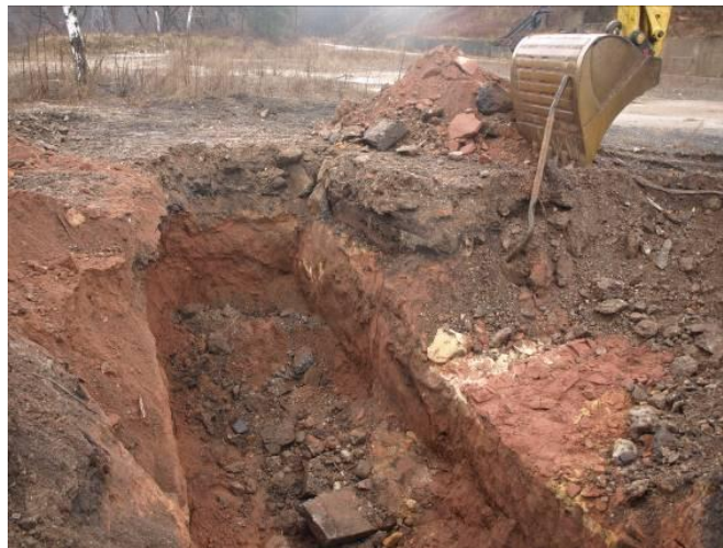
Illustration 213 - Sondage à la pelle au contrôle V6, Freyming-Merlebach (57).
