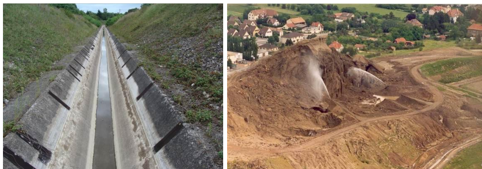
Illustration 245 - Saumoduc dans sa partie canal béton – Dissolution du terril Fernand, bassin potassique alsacien.
