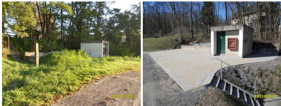
Illustration 49 - La Houve : Travaux de réalisation d'une plate forme au abords local technique.
