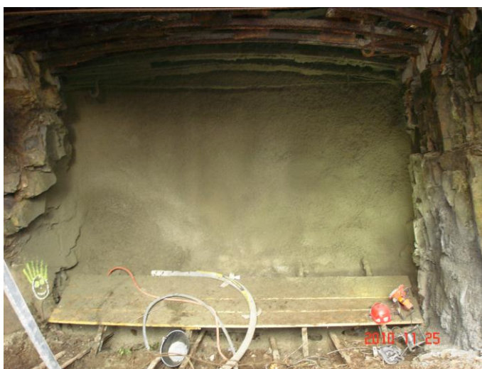
Illustration 168 - Descenderie de l'Oudon : Vue du pré-bouchon, Segré (49).
