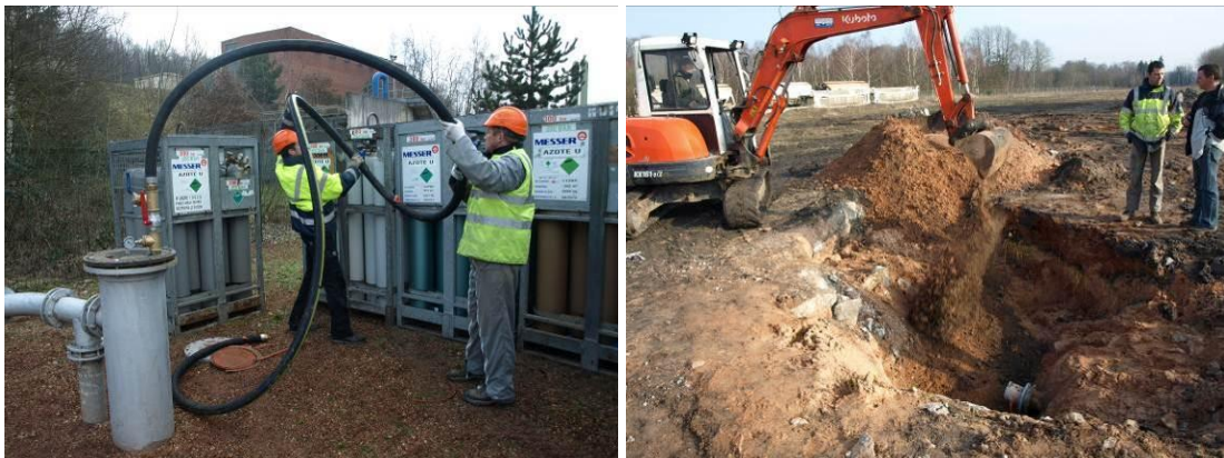
Illustration 207 - Puits 2 (Jules) : Inertage à l'azote - Puits 3 : Orifices des conduits bouchés, La Houve.
