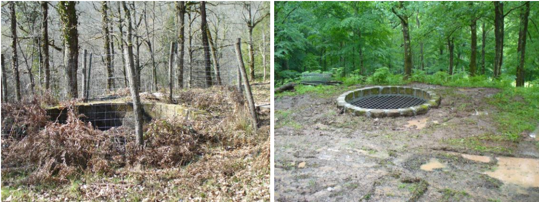
Illustration 151 - Puits Albert : avant - après travaux à Cublac (19).
