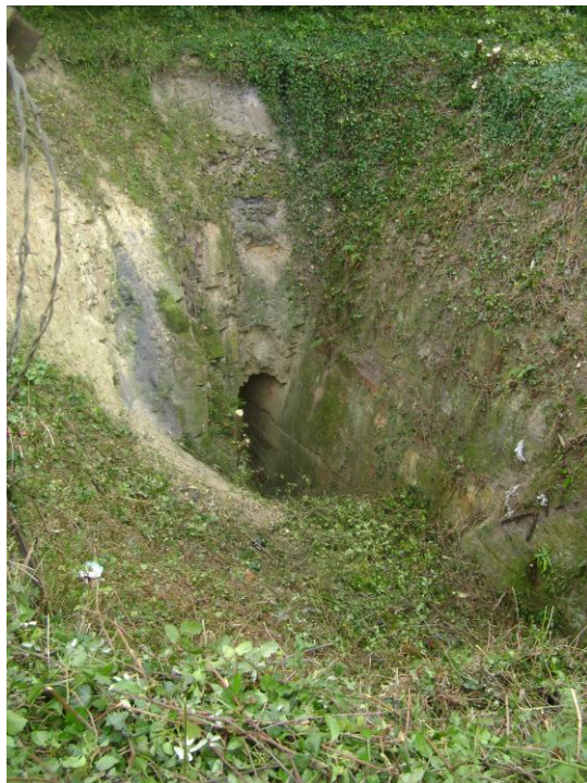
Illustration 171 - Vue des orifices des chambres d'exploitation au fond de l'effondrement des Aulnaies, Nyoiseau (49).
