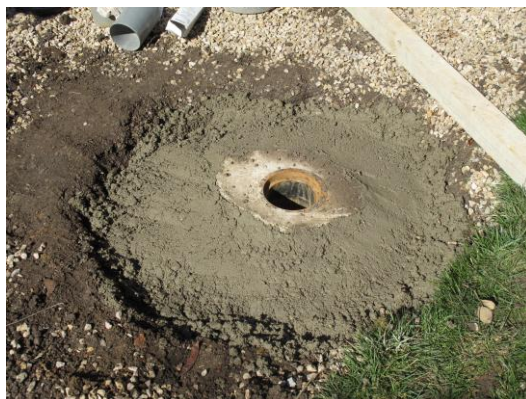
Illustration 54 - Travaux sur le forage 596 à la Chapelle-sous-Dun (71).
