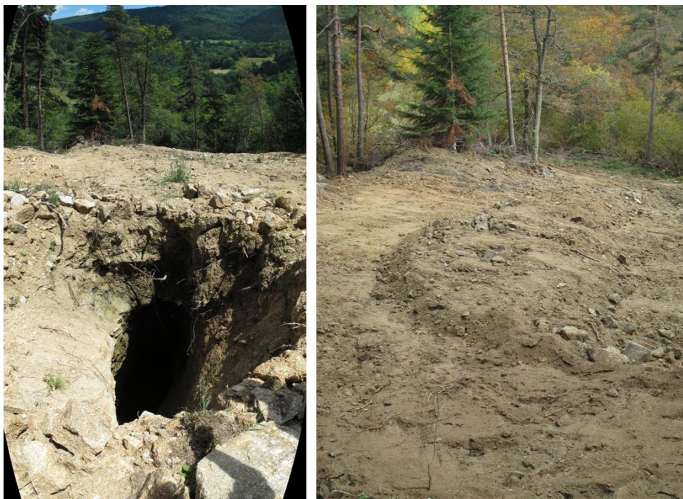
Illustration 143 - Traitement du SIG 23 : avant - après travaux sur la vallée de la Senouire (43).
