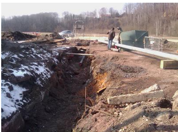
Illustration 108 - Pose de la conduite de liaison entre les puits Vuillemin 1-2, commune de Petite Rosselle (57).
