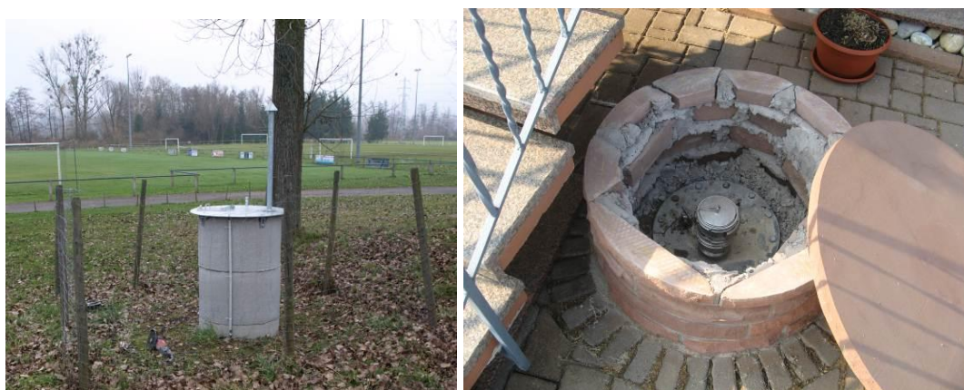
Illustration 123 - Ouvrage 108 avec son nouveau couvercle à Durenbach (68) – Ouvrage 3732 à Soultz-sous-Forêt (68).
