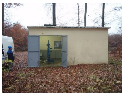
Illustration 33 - Forage F239, le bâtiment à Creutzwald (57).
