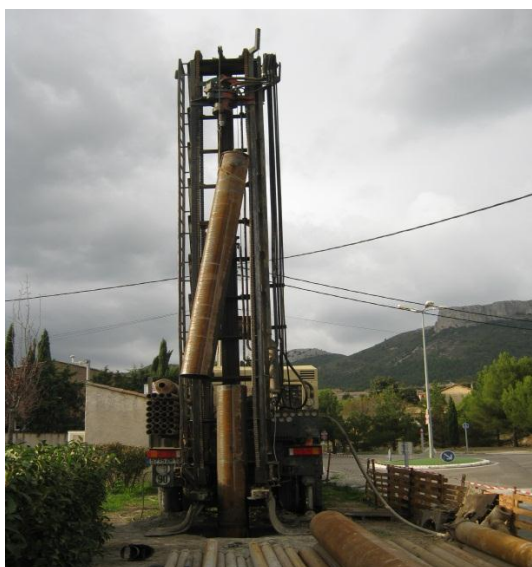
Illustration 183 - Travaux de forage et mise en place sonde microsismique à Cadolive (13).
