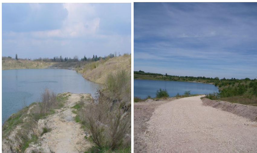
Illustration 7 - Lac Saint-Amédée : chemin d'accès, avant et après travaux, commune de Sauvigny-les-Mines (71).
