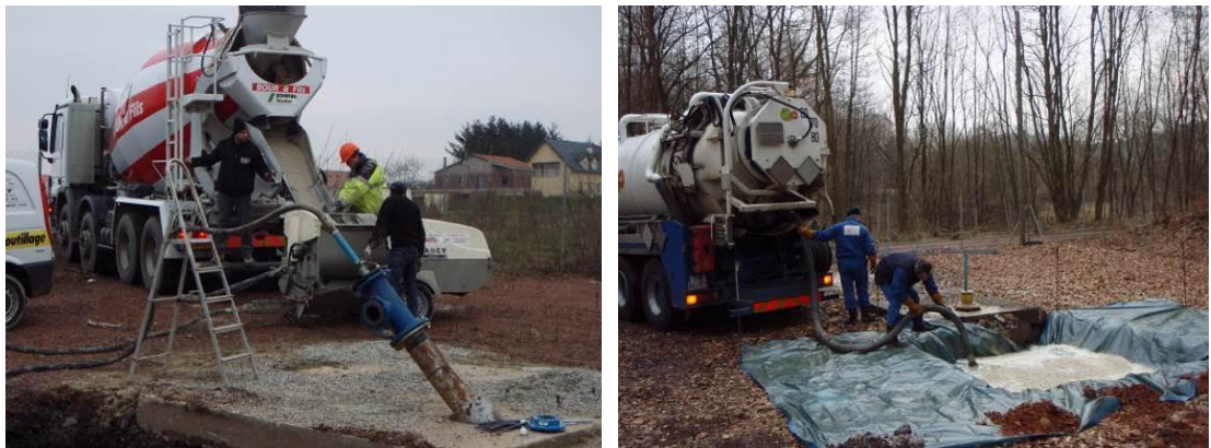
Illustration 205 - Sdec Ouest 3 : En cours de bétonnage - Récupération de l'eau souillée, La Houve, Creutzwald (57).
