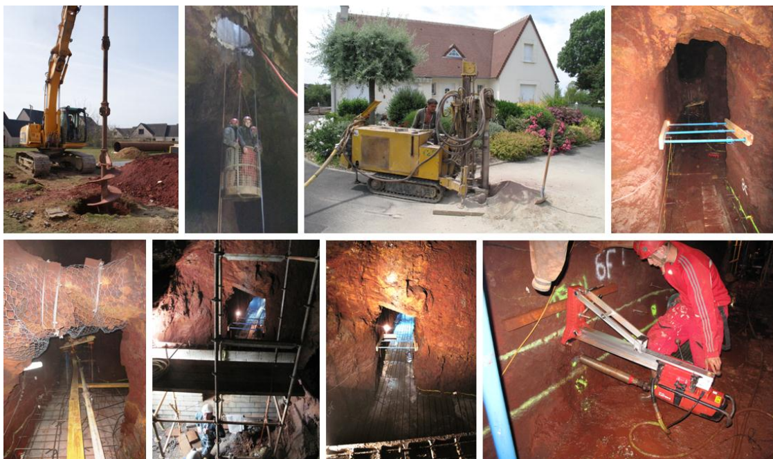
Illustration 141 - Mise en sécurité d'un pavillon à Saint-Martin-de-Fontenay (14).
