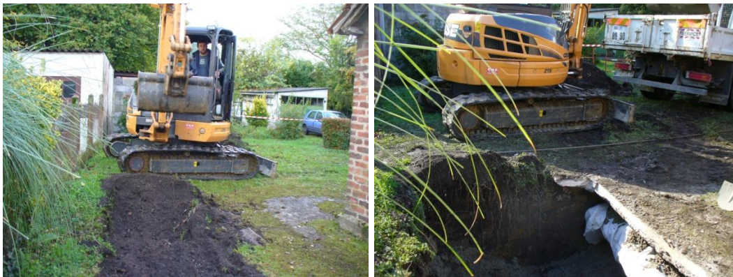
Illustration 162 - Habitation au 7, Rue de la Chapelle : Terrassement à l'Est du puits, La Machine (58).
