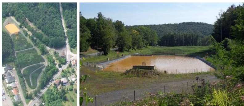
Illustration 47 - Lagune de la Houve : bassin de décantation.
