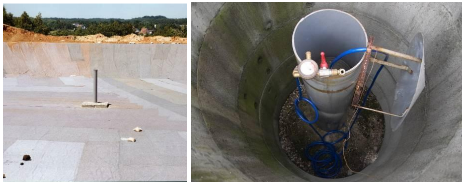
Illustration 237 - Cheminée du gazomètre : Actuellement - Lors de de sa réalisation, Morsbach (57).
