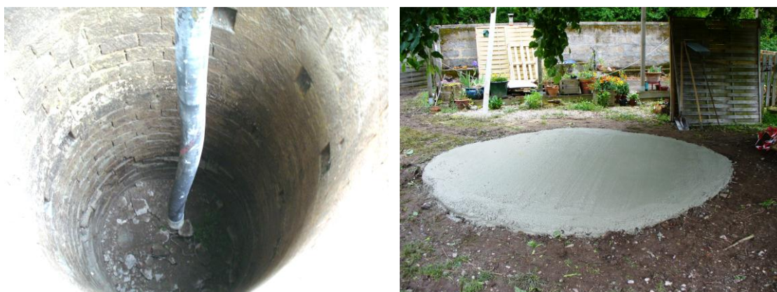
Illustration 150 - Puits Sainte-Barbe : avant - après mise en place du bouchon à Cublac (19).
