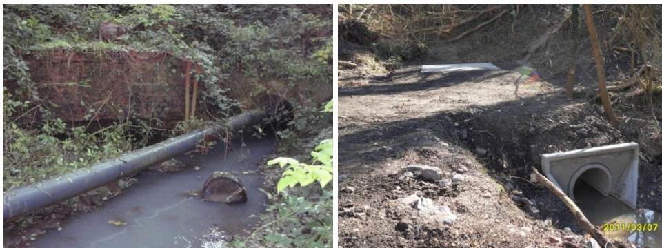
Illustration 48 - La Houve : Travaux de sécurisation de la conduite de liaison.
