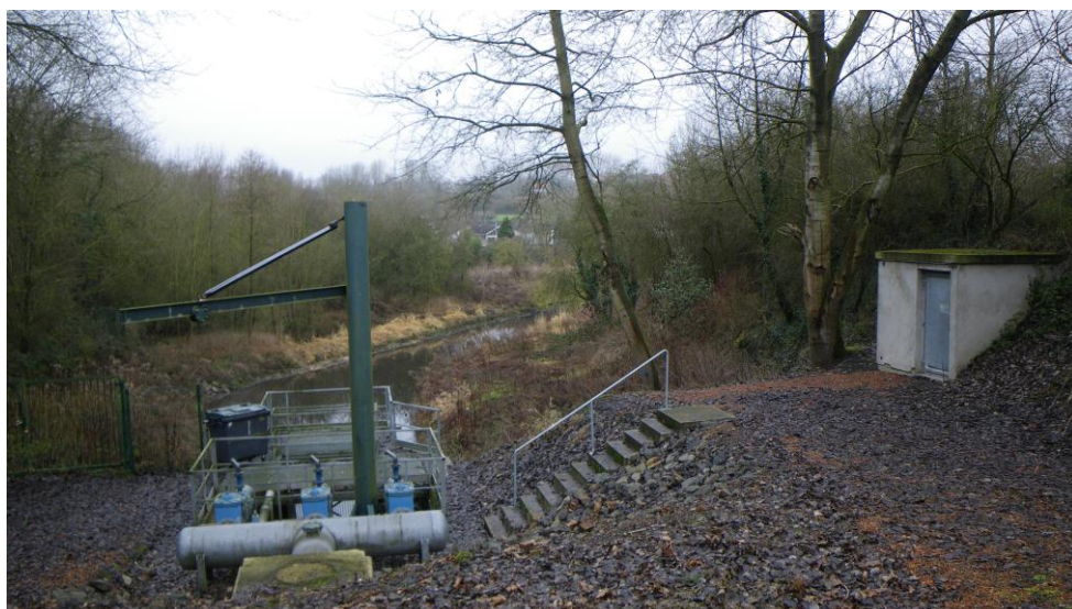
Illustration 139 - SRE Amont et son bassin de rétention à Bruay-la-Buissière (62).
