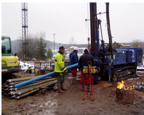
Illustration 232 - Forage du nouveau piézomètre PZ Gazomètre Amont, Morsbach (57).
