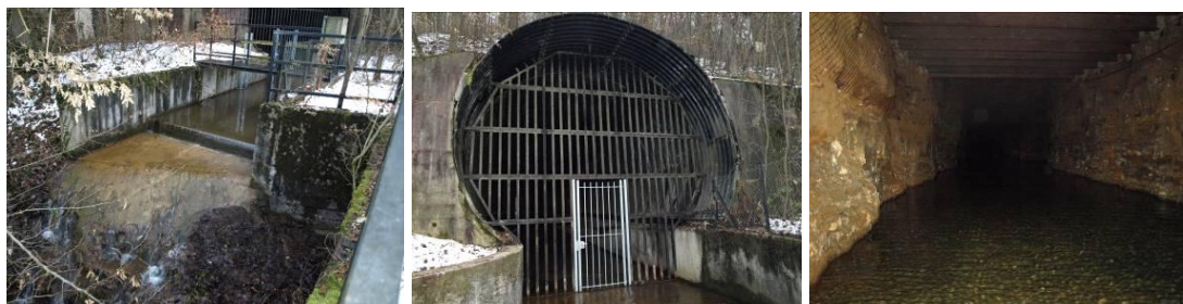
Illustration 24 - Galerie du Bois d'Avril : Déversement dans le Conroy - La grille d'accès - La galerie.
