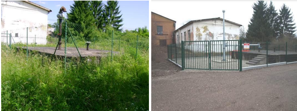
Illustration 129 - Puits 1 à Preusdorf (67) : Exutoire avant - après travaux.
