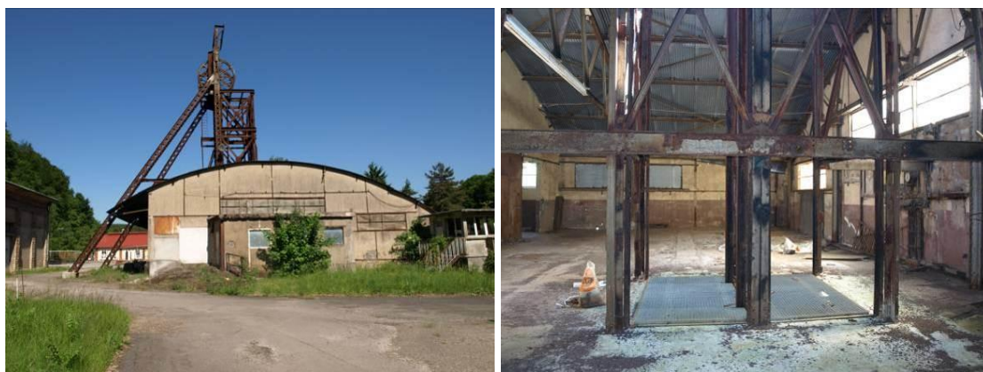
Illustration 93 - Puits 2 : Vue générale - Grille en tête de puits à Audun-le-Tiche (57).
