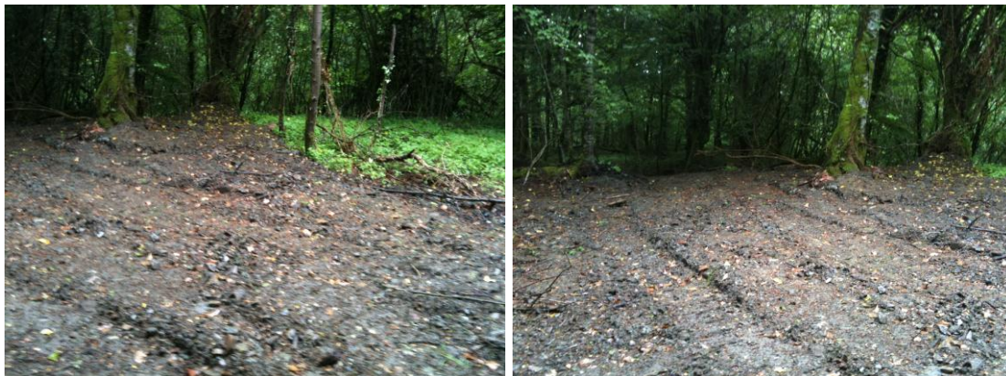
Illustration 145 - « Le Bas Vallon » - Infrastructures béton (après travaux) à L'Hermitage-Lorge (22).
