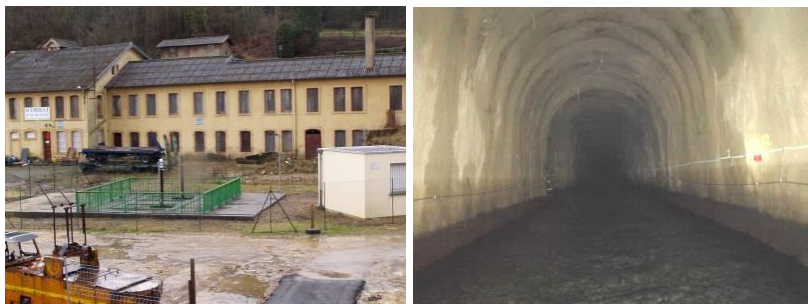
Illustration 26 - Galerie de Moyeuvre-Grande : Ouvrage amont et le local technique - État de la galerie en 2010.
