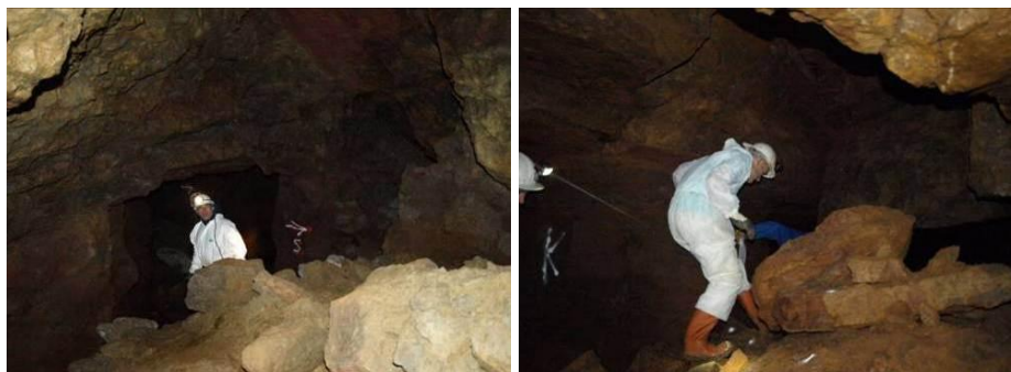
Illustration 78 - Galeries du circuit Franchepré jonchées de gros blocs tombés du toit, commune de Moyeuve-la-Grande (57).
