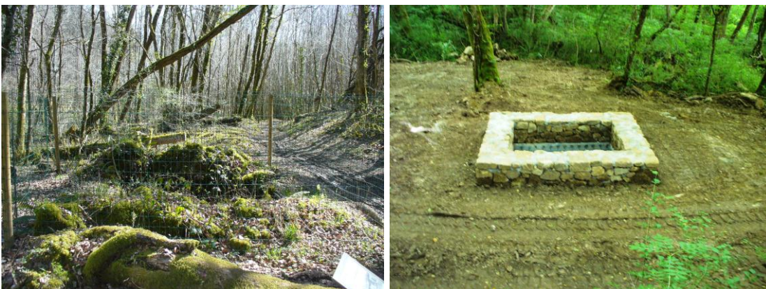
Illustration 153 - Puits Vieux : avant - après travaux, Cublac (19).
