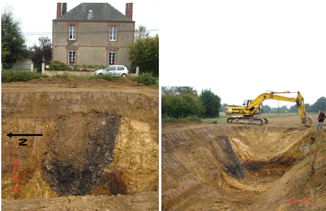
Illustration 172 - Vue de l'habitation, de l'ancien puits d'aérage et de la couche de minerais grâce à la tranchée de reconnaissance, lieu-dit le Chat, Noyant-la-Gravoyère (49).
