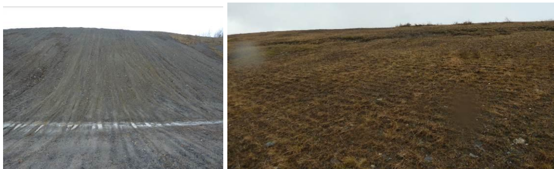
Illustration 64 - Terril siège 2, La Houve : traces de motos - affaissement ayant généré une ligne de rupture.
