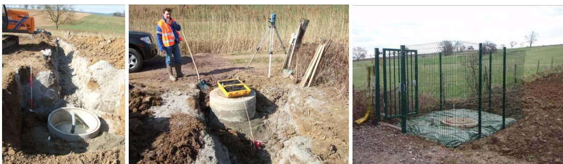
Illustration 218 - Forage 945 : Tête - Virole d'accès au séparateur – Ouvrage terminé, Kutzenhausen (67).
