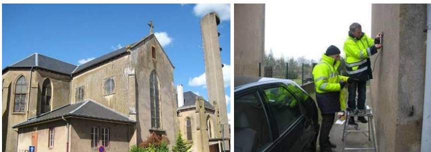
Illustration 66 - Église de Joeuf (54) - Mesures d'inclinométrie à Roncourt (57).
