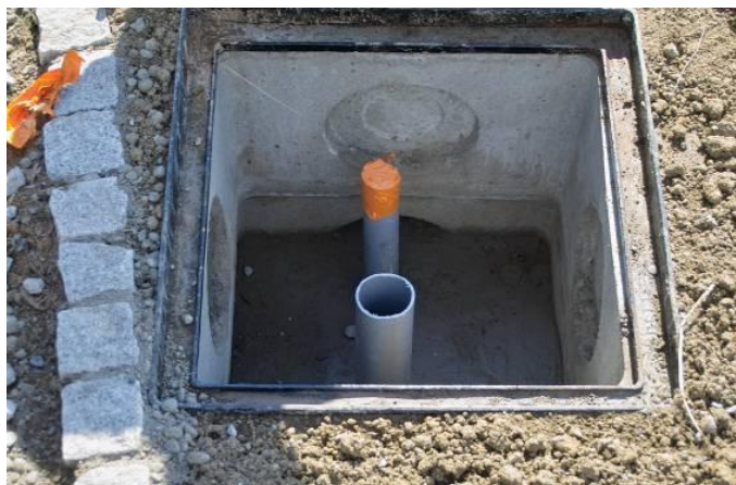
Illustration 121 - Mesure du radon : Regard de la sonde à Belle-Roche, Cocheren (57).
