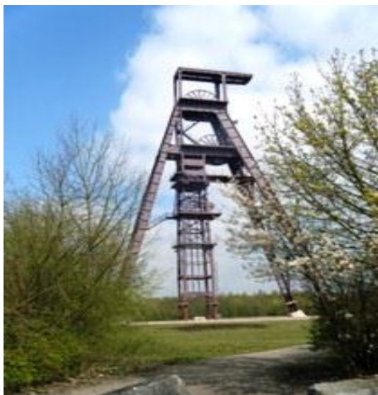
Illustration 52 - Tête de puits matérialisée Ledoux 1 à Condé-sur-Escaut (59).
