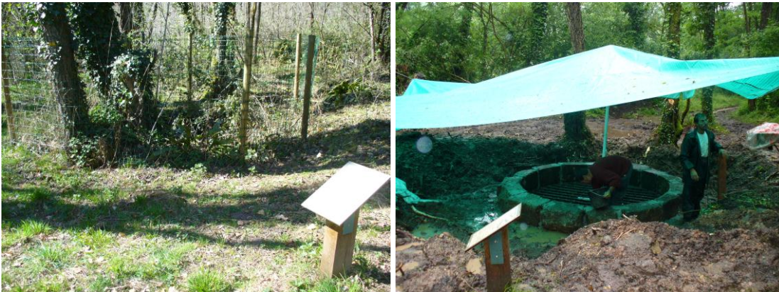
Illustration 152 - Puits Festugière : avant - pendant les travaux, Cublac (19).
