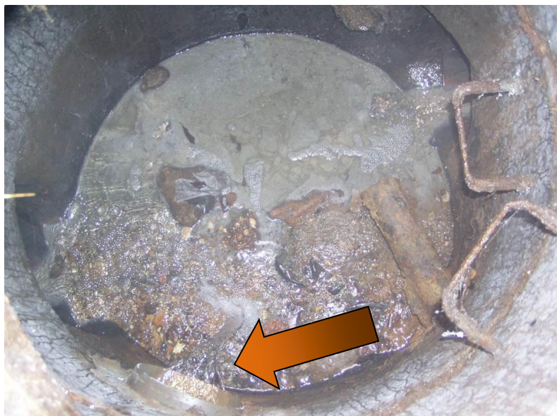
Illustration 239 - Le regard d'arrivée du probable drain gazomètre, Morsbach (57).
