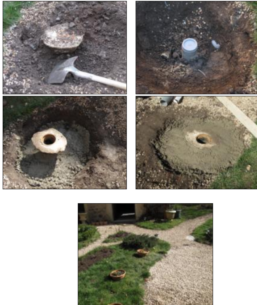
Illustration 161 - Forage 596 : pendant - après les travaux, La Chapelle-sous-Dun (71).
