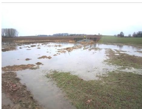
Illustration 125 - Ouvrage 3059 lors d'une crue du Sumpfgraben à Kutzenhausen (67).
