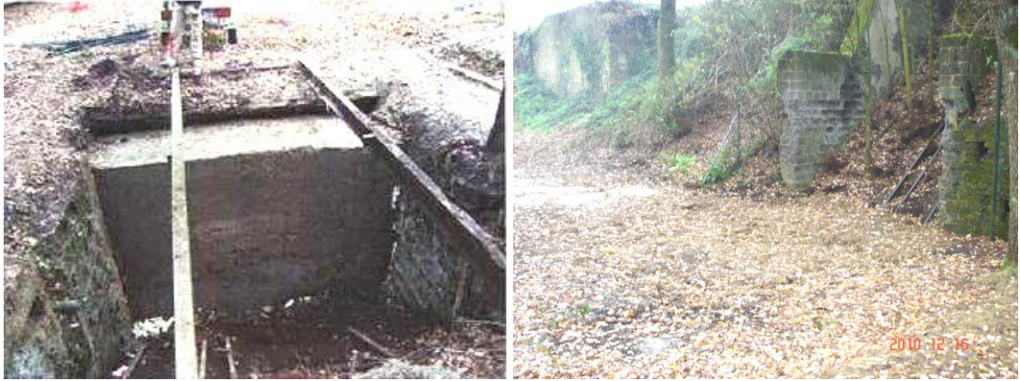
Illustration 169 - Descenderie de l'Oudon : Vue du bouchon - site après travaux, Segré (49).
