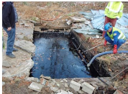
Illustration 216 - Puits 6 : Bac de pétrole découvert, à Kutzenhausen (67).
