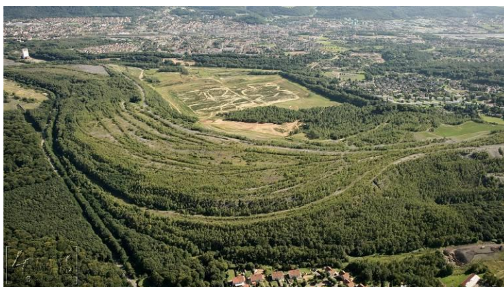
Illustration 39 - Terril de Wendel, étendu et plat, édifié par voies ferrées, Forbach (57).
