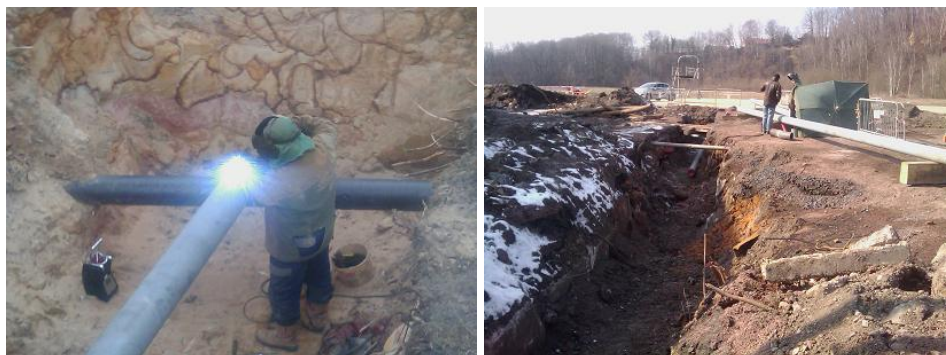
Illustration 210 - Raccordement de la nouvelle conduite de liaison vers le puits Villemin 1 - Tranchée d'installation, Petite Rosselle (57).
