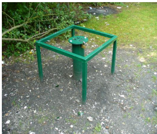
Illustration 223 - Piézomètre remis en état : avant - après à Escaudin (59).
