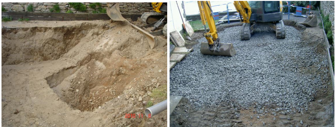
Illustration 180 - Fontis : Excavation du fontis - mise en place du ballast, Piriac-sur-Mer (44).
