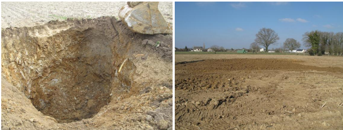
Illustration 177 - Vue du fontis excavé et comblé, Saint-Erblon (53).
