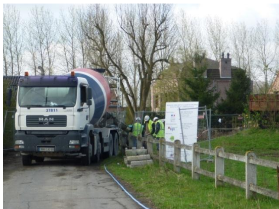
Illustration 134 - Coulis remplissage du puits 1, à Annoeullin (59).
