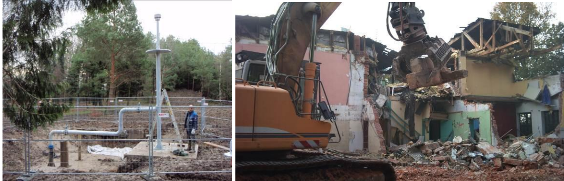
Illustration 215 - Puits 6 : Mise en place du nouvel exutoire – Démolition des bâtiments à Kutzenhausen (67).
