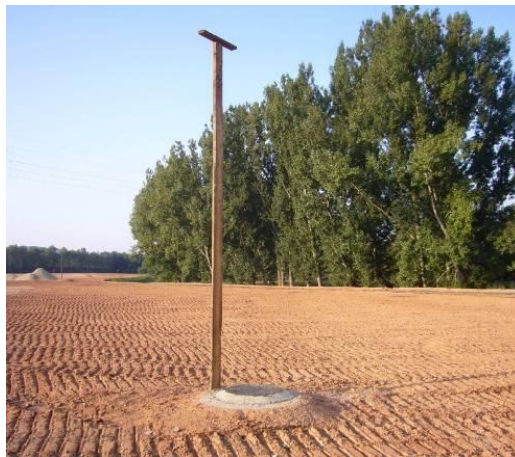
Illustration 230 - Puits de surveillance de la nappe perchée, Triangle de Marienau, Morsbach (57).
